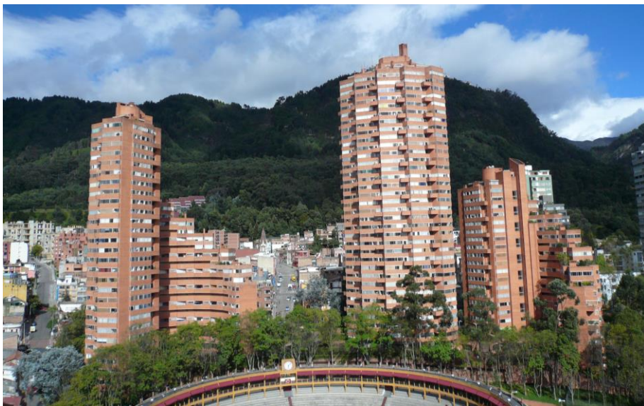
Fig. 9. Residencias El Parque, vista del conjunto. Fuente: elaboración propia.
