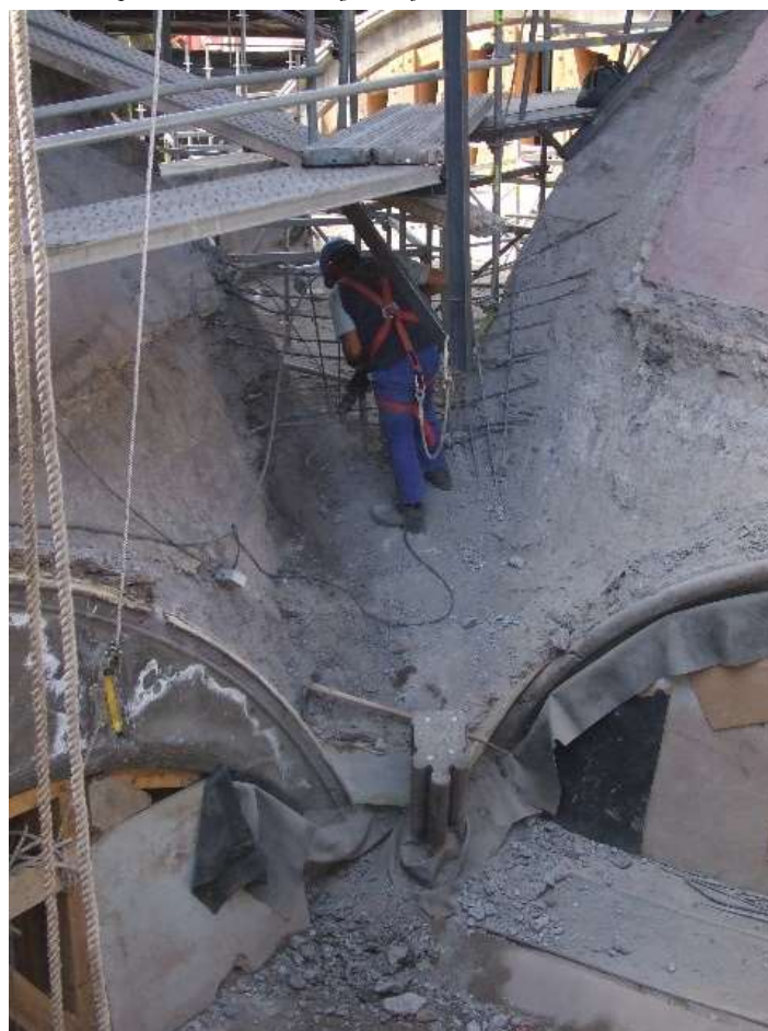
Figura 194, fotografías de la demolición de las cubiertas cedidas por Víctor Rodríguez e hijos, empresa Constructora. Se puede observar la zona de rellenos que queda entre las bovedas en comparación con la altura del trabajador.
