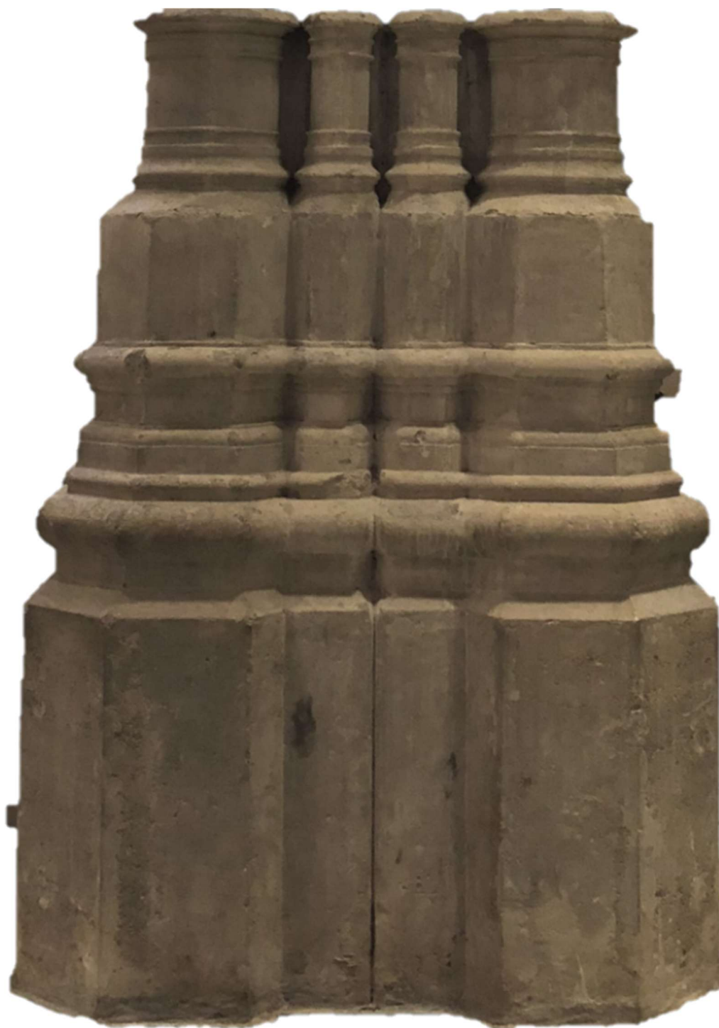
Figura 154, detalle de la base de la columna tipo en el crucero, el hormigón visto simulando el acabado de piedra natural. Fotografía del autor
