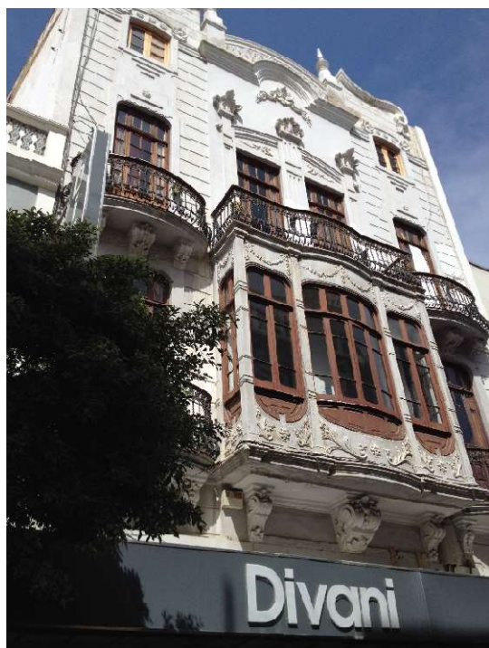
Figura 95 edificación de Fernando Navarro del año 1922 con pórticos de hormigón armado en planta baja. Los pilares, de planta circular y las vigas con cartelas curvas en su encuentro con los pilares. Fotos del autor.
