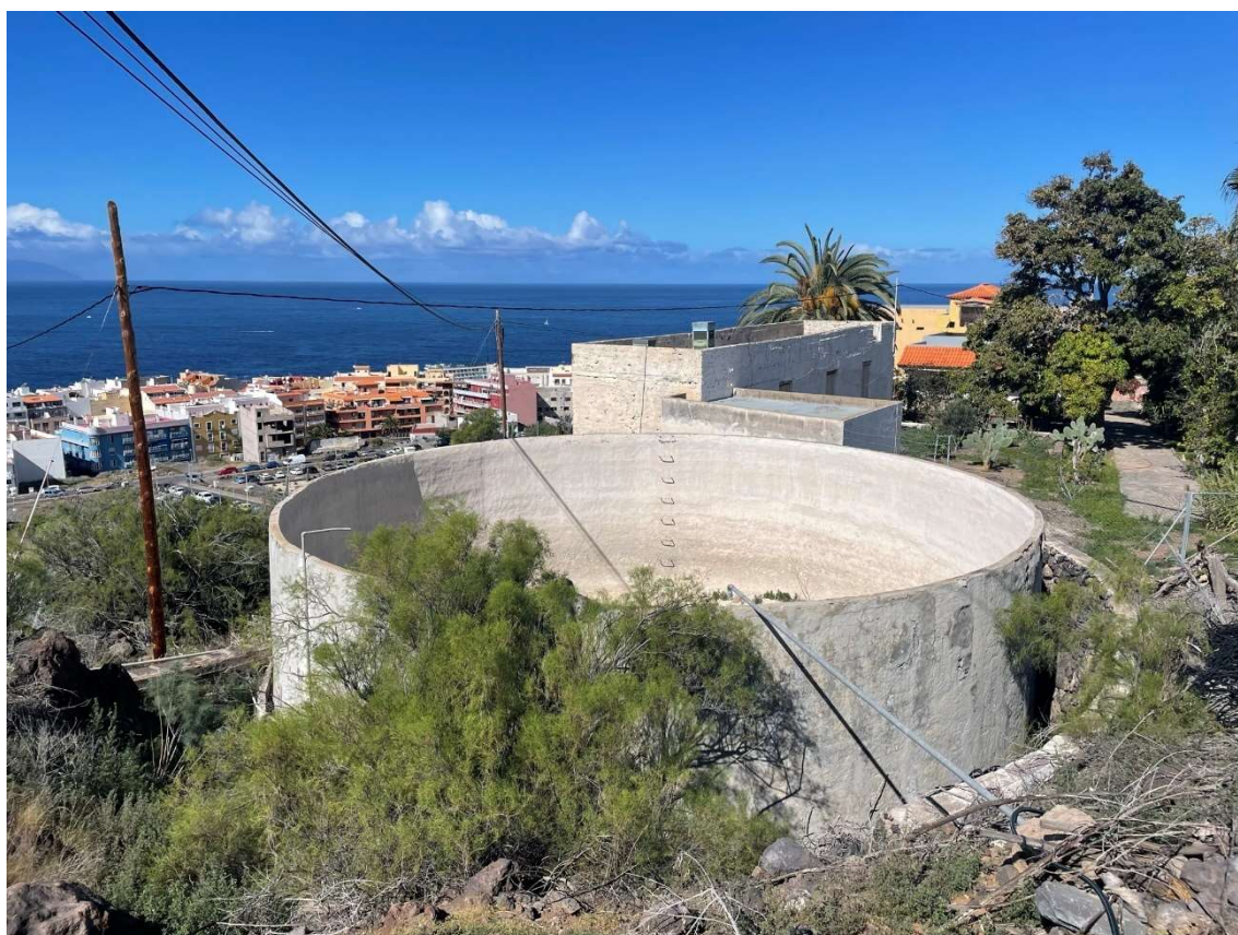
Figura 72, Estanque redondo de hormigón armado en el sur de la isla de Tenerife. Foto del autor
