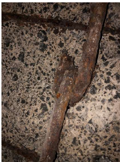
Figura 112, detalle de las armaduras de los forjados: empalme de barras con ganchos. Convento de San José 1905. Fotografía del autor
