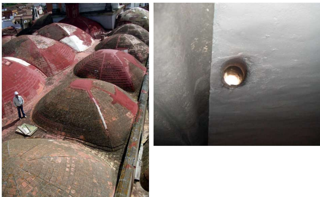
Figura 202, fotografías de la cubierta, antes de la demolición, y de las ventilaciones originales de las bóvedas. Informe de Francisco Jurado, Arquitecto, relativo al Estado Estructural de la Catedral de La Laguna, encargado por el IPHE (2008)
