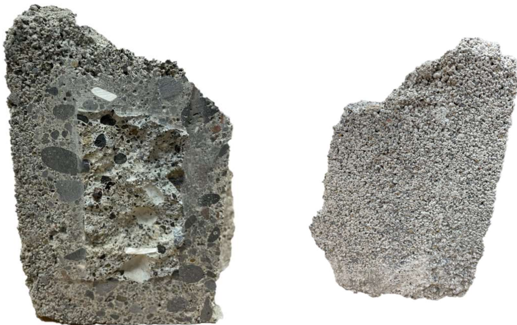
Figura 231, muestra del hormigón del molde o encofrado perdido para ensayo de difracción, sección transversal a la izquierda y cara exterior a la derecha. Fotografía del autor.
