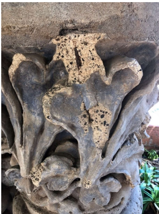
Figura 158: detalle de los elementos decorativos realizados con mortero de cal y áridos ligeros, en este caso, columnas de la nave. Foto del autor
