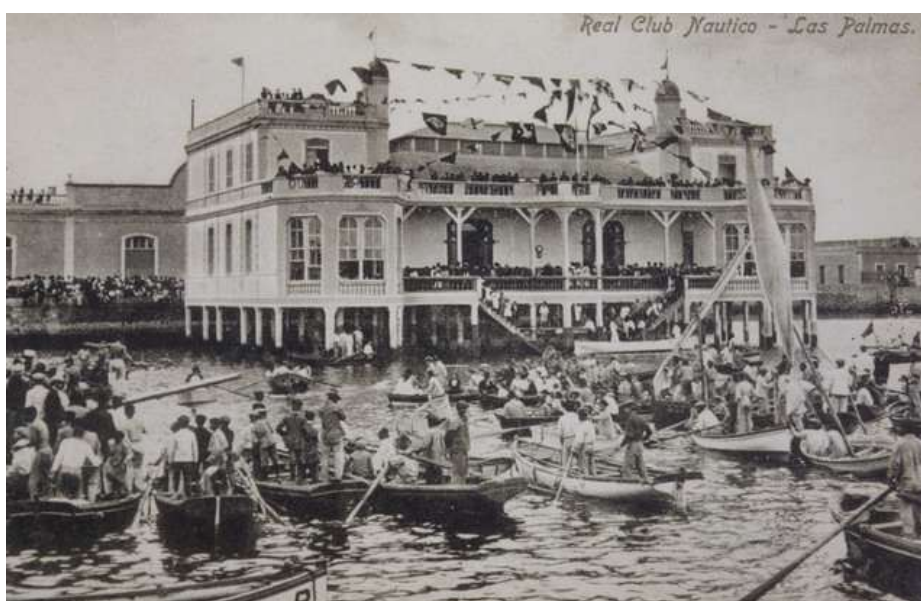
Figura 115. El club Náutico de Las Palmas, construido entre 1908-1909 por el Ingeniero Militar Adolfo San Martín. La primera gran obra de hormigón armado de la Ciudad de Las Palmas. Fuente Fedac.
