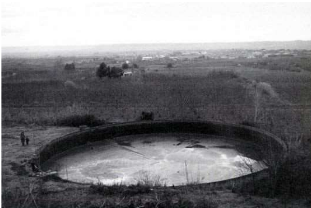
Figura 71: El depósito de agua de Puigverd de Frances Macia i Llusà (1893). Fuente CEDEX-CEPOHU
