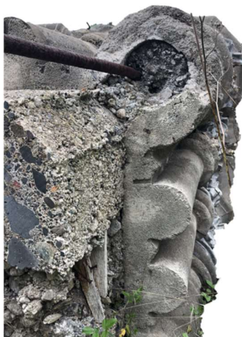
Figura 149, detalle de encuentro del hormigón del núcleo central y el molde. En este caso el molde parece tener solo un tipo de mortero, probablemente debido al proceso de ejecución. Foto del autor
