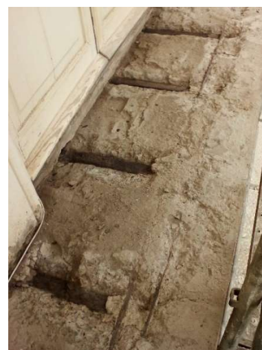
Figura 14. Fachada naciente: detalla de barras de hierro para armar los voladizos de hormigón armado. Fotografías facilitadas por la Constructora Preconce SL, adjudicataria de las obras de rehabilitación del edificio según proyecto de la arquitecta y profesora María Luisa González
