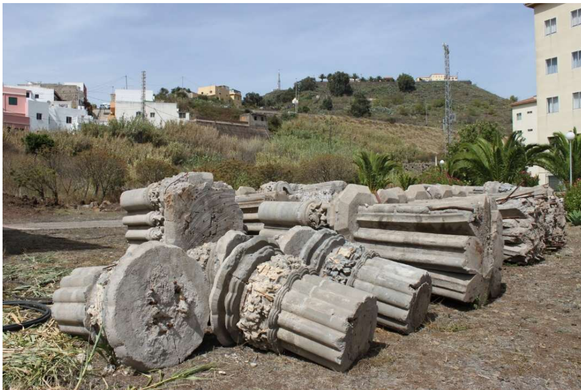
Figura 218: fotografía de los restos de la demolición depositados en el Seminario Diocesano de Tenerife, al poco tiempo de ser trasladados desde un vertedero próximo. Publicada en la revista “El Verdeño” de la Asociación de vecinos de la Verellada, el 25 de Septiembre de 2010
