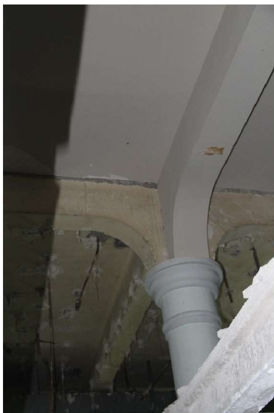
Figura 95 edificación de Fernando Navarro del año 1922 con pórticos de hormigón armado en planta baja. Los pilares, de planta circular y las vigas con cartelas curvas en su encuentro con los pilares. Fotos del autor.
