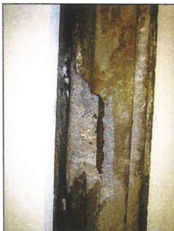
Figura 212: efloras en la cornisa interior de la base de la cúpula. Imagen del informe 19261 de. IETcc.
