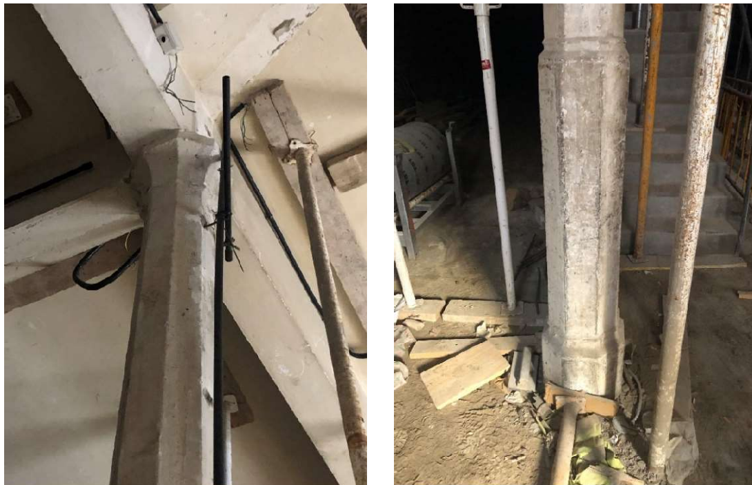
Figura 97 detalles de los pilares de planta baja con sección octogonal, con su plinto de arranque y capitel. Arquitecto Fernando Navarro, calle Alonso Alvarado 15, año 1923. Foto del Autor.
