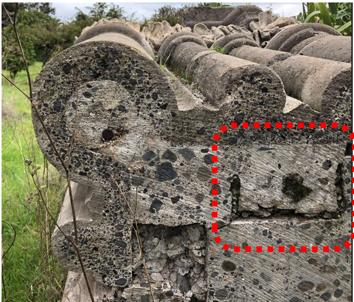
Figura 151, detalle de la sección de la columna tipo del crucero. Seminario de la Verdecilla. Foto del autor.
