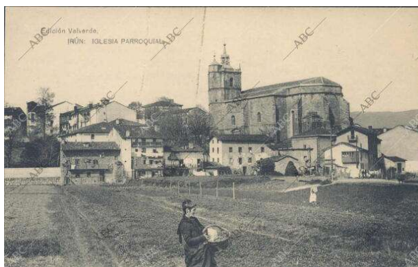
Figura 84: a la izquierda vista de los encofrados de madera para el hormigonado de los arcos principales de esta cubierta de 1910-12. Fotografía de la revista Memorial de Ingenieros, de diciembre de 1912. Sobre este texto foto antigua de la parroquia. Hemeroteca del periódico ABC
