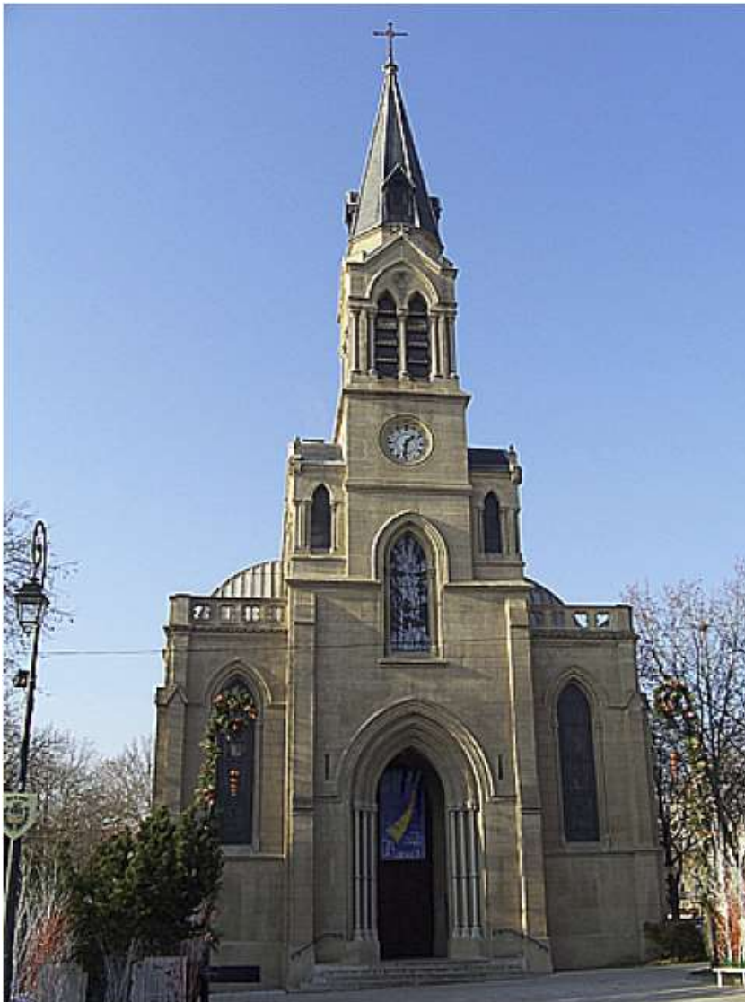
Figura 46, la Iglesia de Sainte Marguerite en Le Vésinet, (1864), construida con hormigón aglomerado, fotografía de la tesis doctoral de Antonio Burgos.
