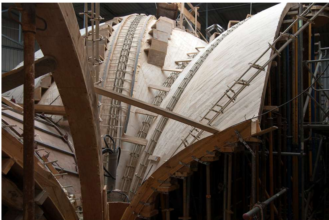
Figura 43, Las nuevas cubiertas de la Catedral de 2014: detalle del encofrado y del armado con armaduras de fibra de vidrio de los nervios de la cubierta. Fotografía de la página web de Cesma. Ingenieros, arquitecto Márquez Zarate.
