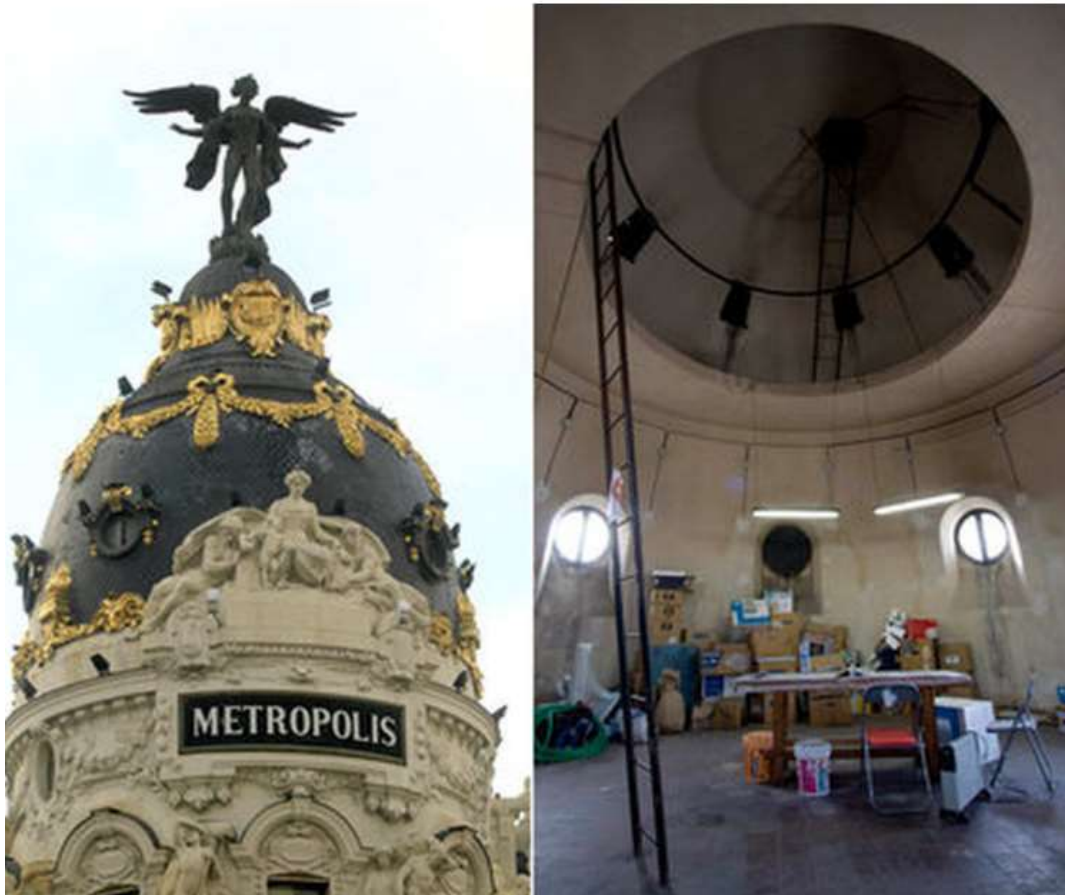
Figura 77, La cúpula de hormigón armado del edificio que remata este espectacular edificio, imagen exterior e interior. Fotografías de El País, 22 febrero 2010-
