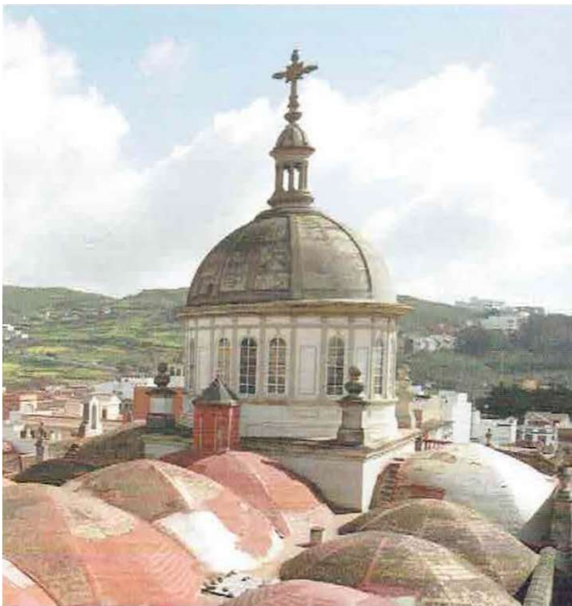
Figura 207, Imagen de la cúpula y de las cubiertas antes de su demolición. Imagen extraída del artículo publicado por Márquez Zárte en la revista Ars Sacra en el año 2005.
