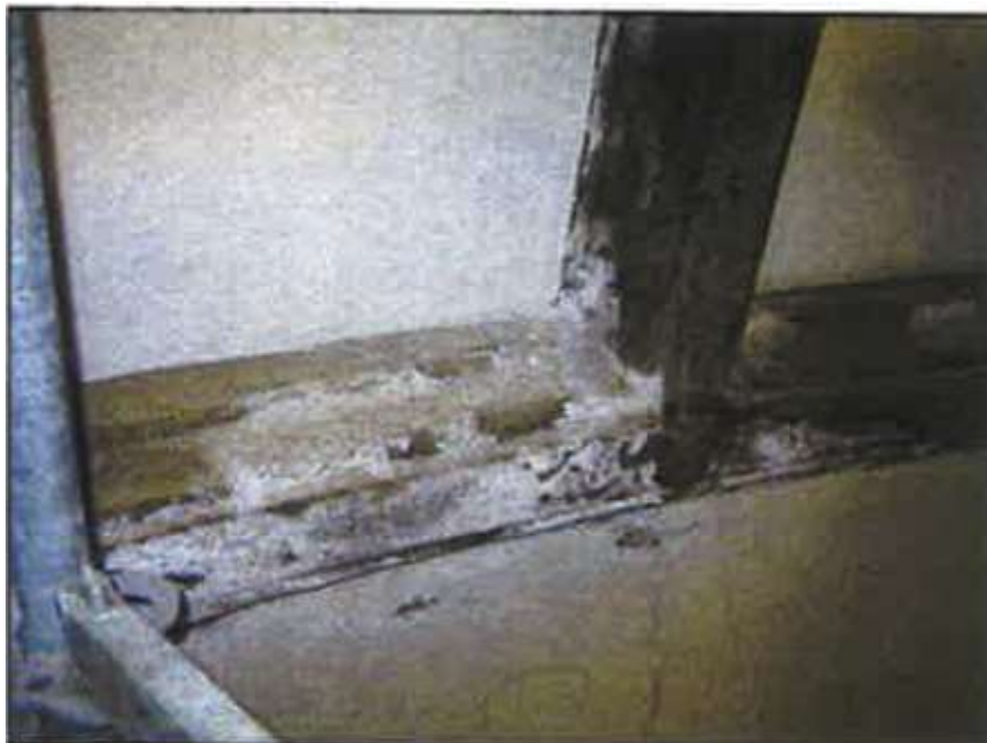
Figura 212: efloras en la cornisa interior de la base de la cúpula. Imagen del informe 19261 de. IETcc.
