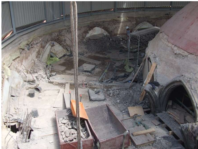
Figura 193, Demolición de las láminas de la zona de la girola. Fotografías cedidas por la empresa Víctor Rodríguez e hijos, empresa responsable de la demolición y de la ejecución de las nuevas cubiertas.
