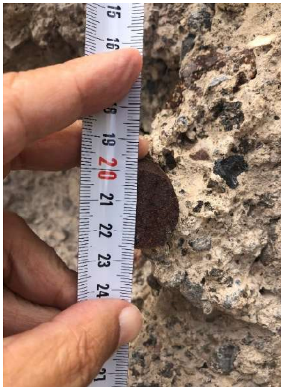
Figura 219: toma de medidas para definir diámetros de las armaduras, foto del autor.
