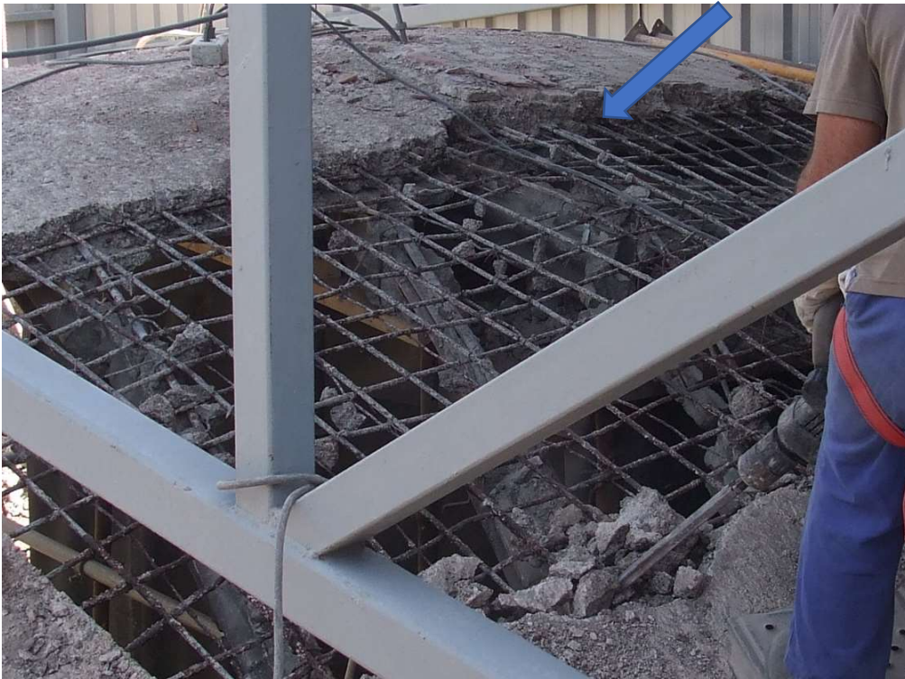
Figura 234: proceso de demolición manual de las bóvedas de crucería. Detalle de los solapes armaduras. Fotografía cedida por Víctor Rodríguez e Hijos, responsables de la obra de demolición de las cubiertas, años 2009-10.
