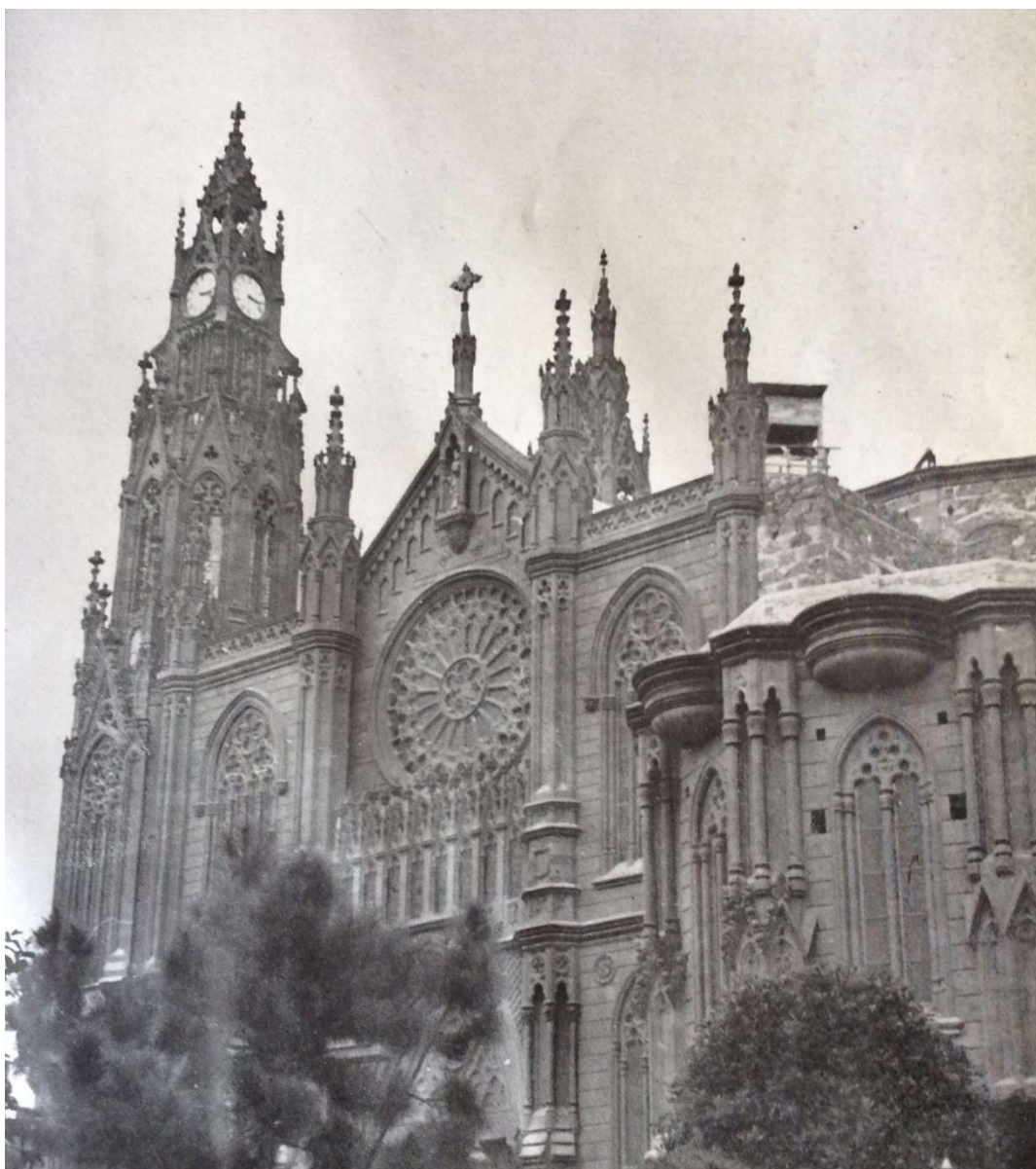
Figura 18: La iglesia de San Juan Bautista de Arucas antes de 1930, obra de Vega March con la torre sur sin terminar. Fondo Fedac, Archivo de fotografía histórica. Fundación para la etnografía y el desarrollo de la artesanía canaria 102
