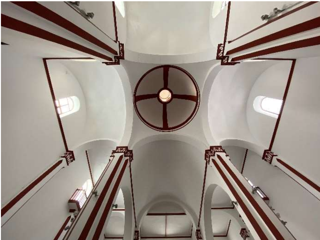
Figura 108, cúpula de hormigón armado de la Iglesia de los Padres Franciscanos en la calle Padre Cueto. Foto del autor
