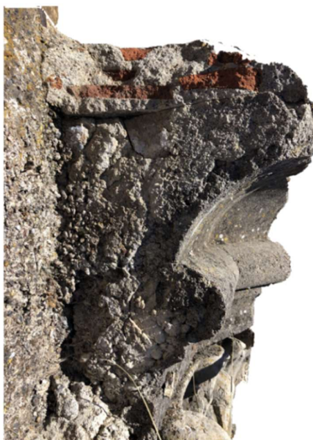
Figura 159: Detalle de la cornisa de la columna de crucero. En la cara exterior una fina capa del mortero visto imitación piedra, detrás un relleno con hormigón y cascotes. Restos depositados en el Seminario de la Verdecilla. Foto del autor.
