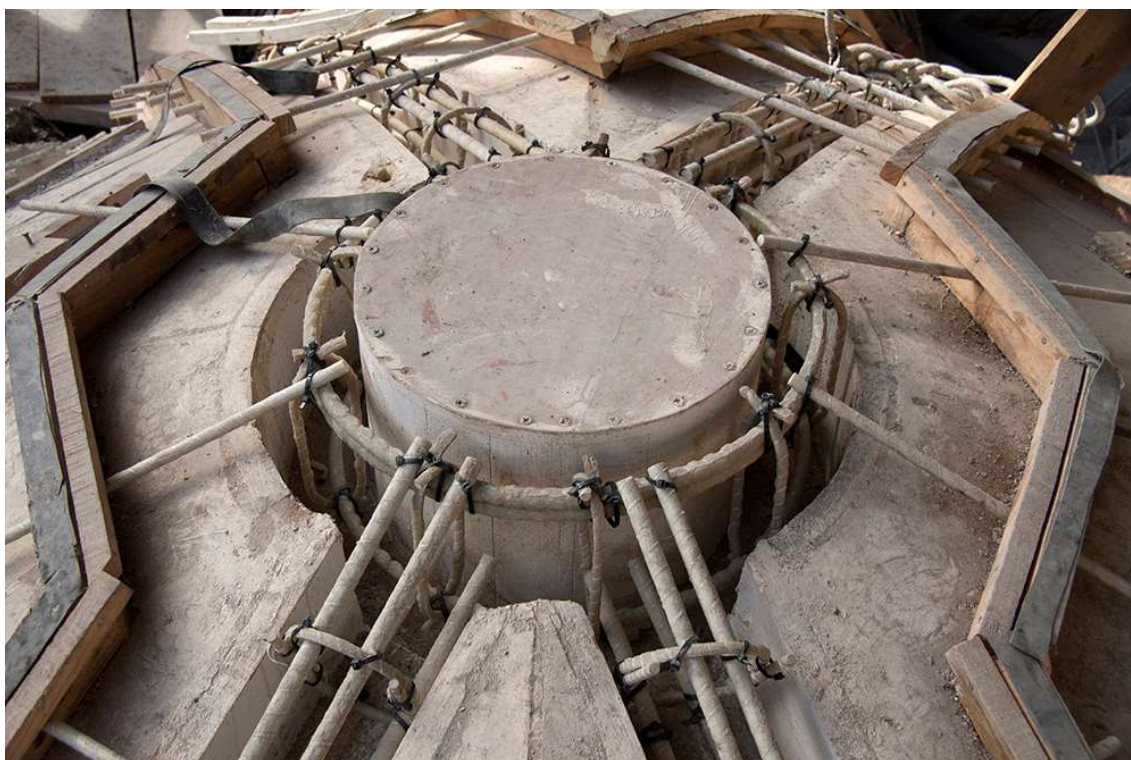
Figura 44: Las nuevas cubiertas de la Catedral del año 2014: detalle del armado de la clave de una de las bóvedas de crucería. Armaduras de fibra de vidrio. Fotográfica extraída de la página web de la consultoría de ingeniería Cesma, arquitecto Márquez Zárate.
