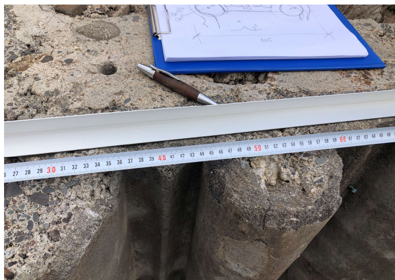
Figura 138, toma de datos de la geometría de las columnas en el Seminario Diocesano de Tenerife. Foto del autor
