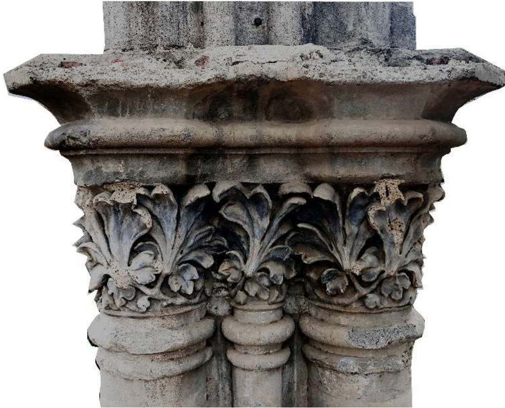
Figura 155: Detalle de la decoración de los capiteles con motivos vegetales, hojas de acanto, realizados con la técnica del vaciado
