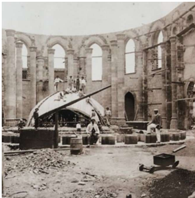
Figura 162. La catedral en construcción en el año 1908. En el centro, monte del encofrado para las bóvedas de las naves laterales
