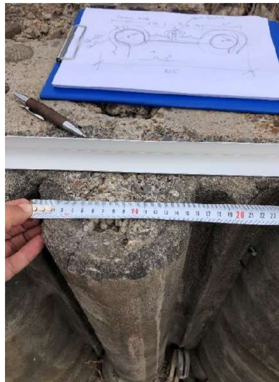
Figura 220: toma de medidas de la geometría de las columnas, foto del autor.
