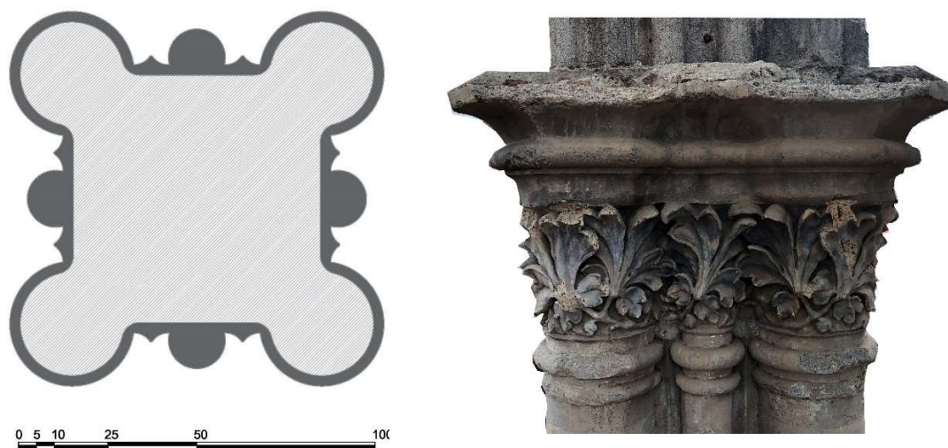
Figura 23, detalle en planta de la columna tipo del primer proyecto de Vallabriga y detalle del capitel decorado con hojas de acanto. Dibujo y foto del autor.
