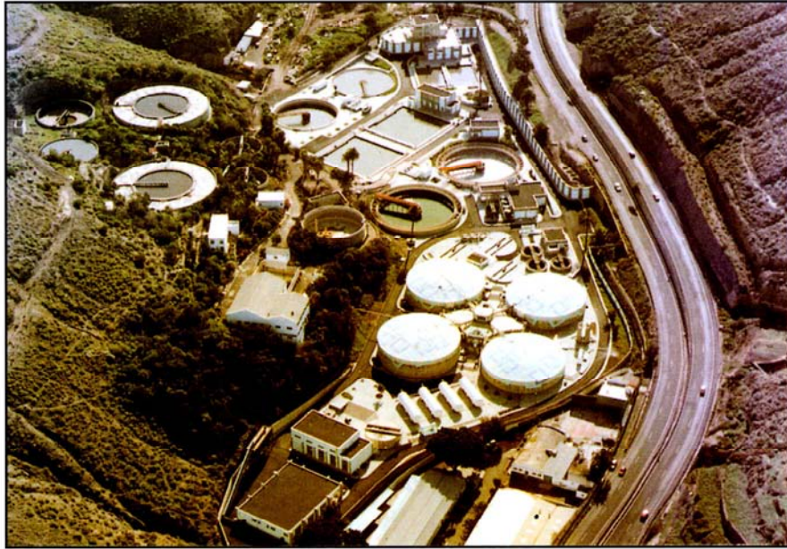
Estación Depuradora de Barranco Seco
