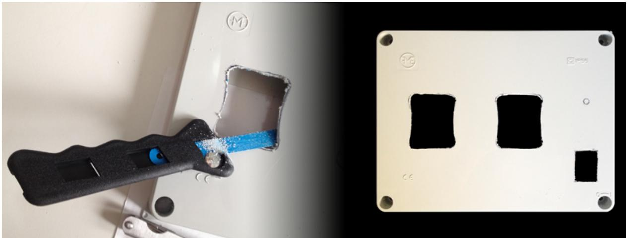
**Ilustración 39: Detalle de las perforaciones en la tapa de la caja**
