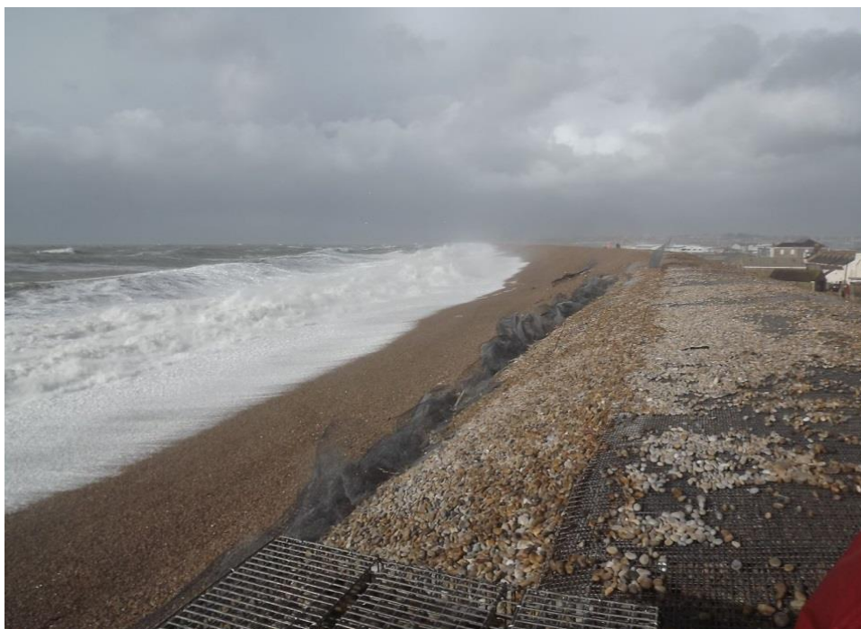
Figura 2: Ilustración del fenómeno de remonte del oleaje y acciones contra la erosión (Ian West)
