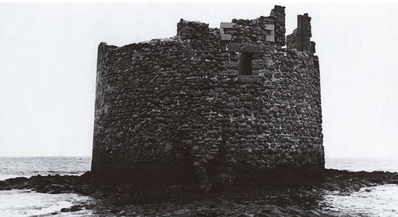
El torreón de San Pedro Mártir, más conocido como castillo de San Cristóbal, 1578, sigue siendo testigo de esa época. [Nieves Sánchez Montero]. Archivo de fotografía histórica de Canarias. FEDAC/Cabildo de Gran Canaria.
