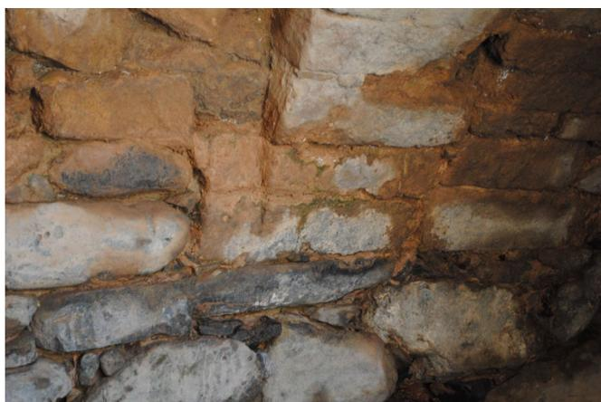
Figura 10. Detalle de las dos dovelas del arco de la bóveda inferior más próximas al estribo norte, retalladas tras su colocación para describir la verticalidad del muro este en lugar de la curvatura de la rosca del arco de la bóveda inferior. Fotografía Archivo Proyecto Rubicón.
