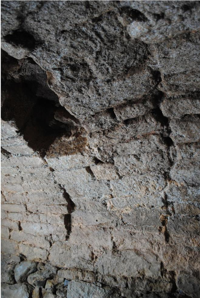
Figura 11. Imagen de detalle de los tramos resultantes de los cambios de posición de la cimbra durante el proceso de construcción de la bóveda inferior. Fotografía Archivo Proyecto Rubicón.
