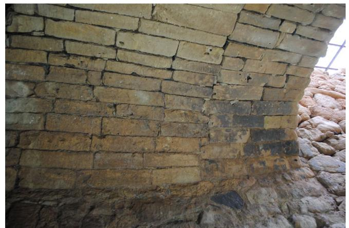
Figura 14. Vista del cuadrante suroriental de la bóveda superior. Se aprecia la junta constructiva entre el arco generador y el resto de la rosca, con engatillados y tacos de relleno. Fotografía Archivo Proyecto Rubicón.
