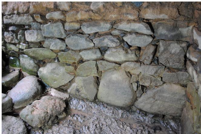
Figura 7. El corte para creación del vaso de captación tiende a subir hacia el sur, lo que obligó a reducir la altura de los bloques empleados en la mitad meridional de la hilada basal del muro oeste para mantener la horizontal de aparejado. Los bloques apoyan directamente sobre el corte en la roca. Fotografía Archivo Proyecto Rubicón.
