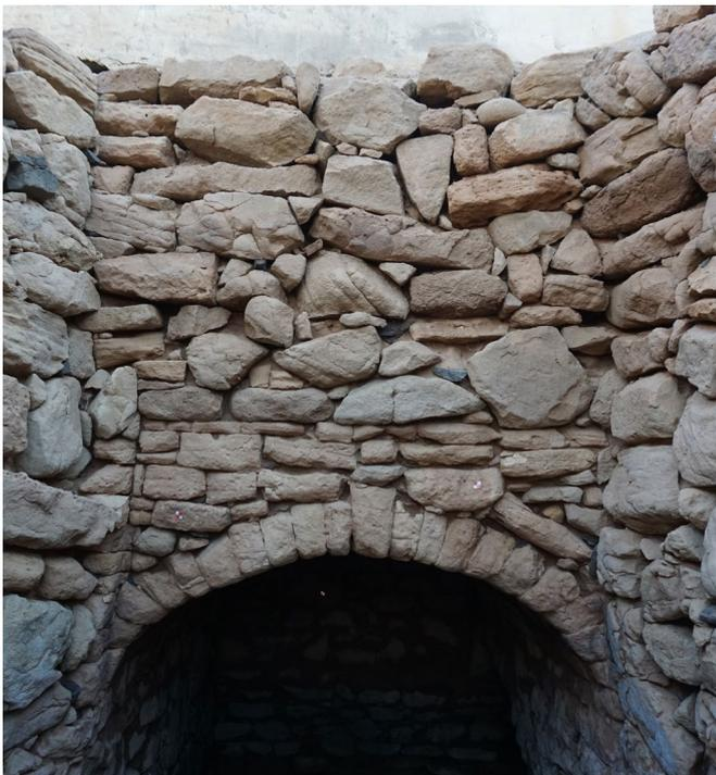
Figura 4. Vista frontal de la fachada sur del pozo de San Marcial en la que pueden verse las dos fábricas. Se distingue claramente la parte inferior de la fachada configurada a modo de alfiz. Fotografía Archivo Proyecto Rubicón.
