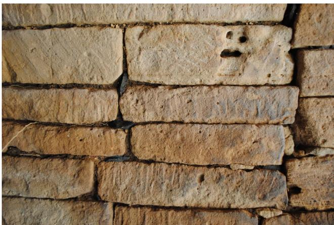
Figura 16. Marcas de hacha, azuela y sierra en el intradós de las dovelas de la bóveda superior. Fotografía Archivo Proyecto Rubicón.
