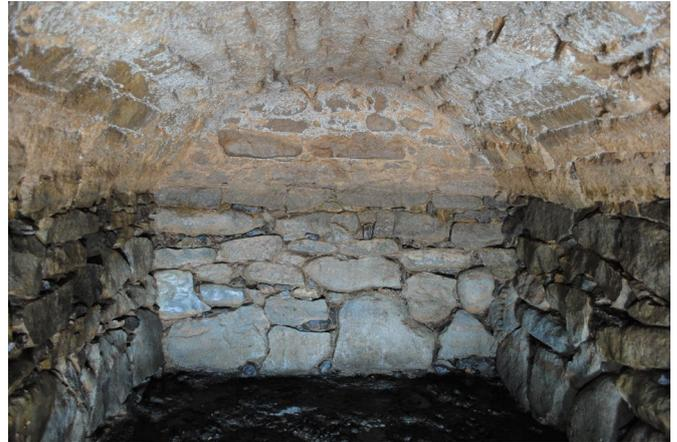
Figura 6. Muro de cierre oriental del vaso de captación. Se aprecia el mayor tamaño de los bloques que constituyen la hilada basal y el tímpano de la bóveda inferior. Fotografía Archivo Proyecto Rubicón.
