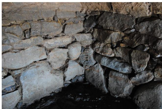
Figura 8. Ángulo sureste de la cámara de captación, en el que se observa la inclusión de un bloque con incisiones horizontales alineadas en vertical, en una única columna, a modo de escala. Se trata, probablemente, de un *aforador*. Fotografía Archivo Proyecto Rubicón.
