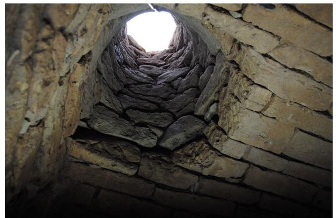
Figura 20. Vista del entibado del tiro vertical del pozo, tomada desde su extremo inferior. A la derecha puede observarse el corte de las dovelas de la bóveda superior, realizado con un pico puntiagudo. Fotografía Archivo Proyecto Rubicón.
