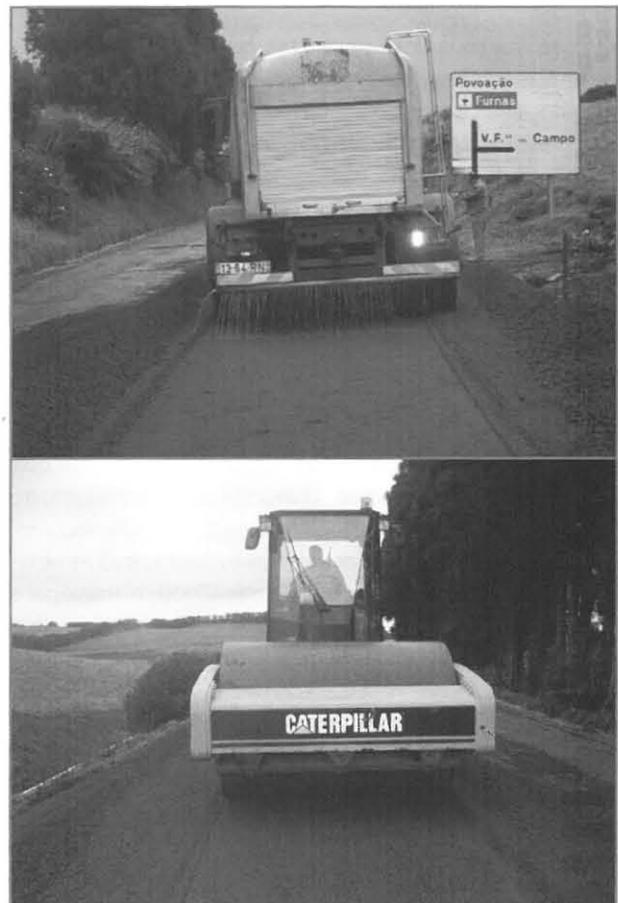
**Foto 5.** Ejecución del tramo experimental sobre pavimento existente (PK 3+600 a 3+700): Humectación y compactación.
