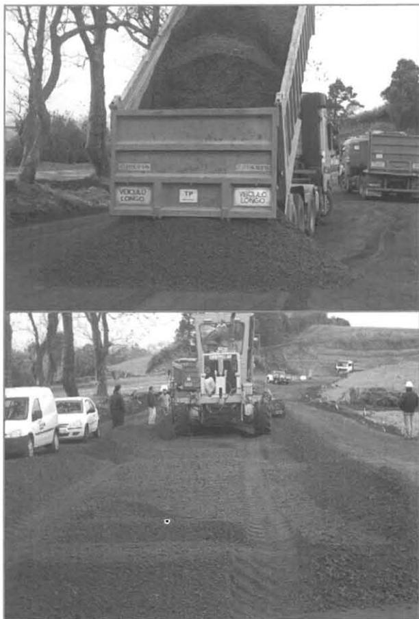
**Foto 2.** Ejecución del tramo experimental con capa de base granular de 0,20 m de espesor sobre explanada de lapilli rojo compactado (PK 0+600 a 0+700): Extensión y nivelación.
