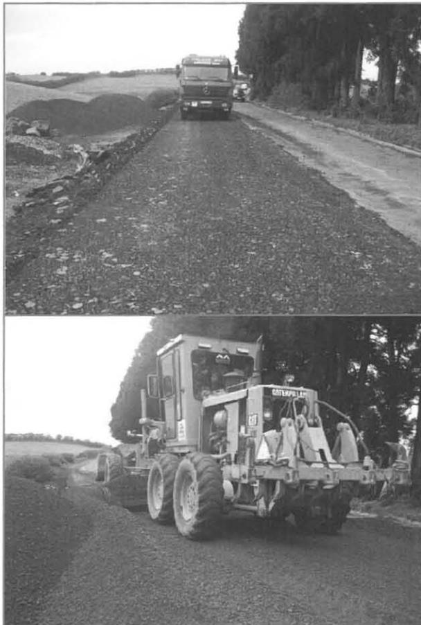
**Foto 4.** Ejecución del tramo experimental sobre pavimento existente (PK 3+600 a 3+700): Escarificado y compactación previa, y posterior extendido y nivelación de la CGGC.
