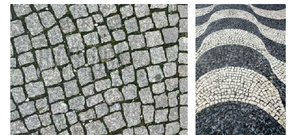
Detalle pavimento exterior
