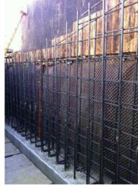
Ejemplo armado muro
