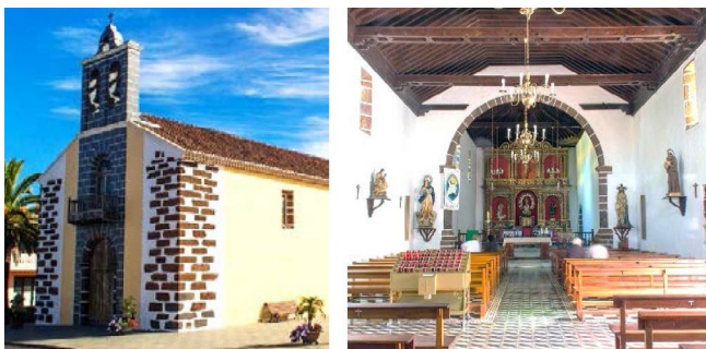
Figura 5. Iglesia de Nuestra Señora del Rosario, en Barlovento, La Palma (1581). UTM 28R - 226465 mE 3192354 mN - 548 m. Es una de las pequeñas iglesias canarias de estructura de fábrica y entramado de madera utilizadas para comparar. Tiene planta con 9 m de ancho y 35 m de largo y una armadura de madera que sigue el tratado de López de Arenas. Fotografías: Ayuntamiento de Barlovento.
