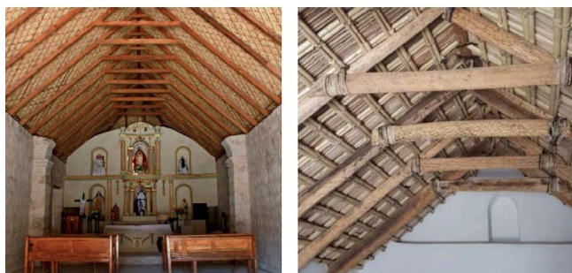
Figura 8: Iglesias chilenas del Altiplano: Izquierda, vista general de una armadura de pares y nudillo sin tirantes. Derecha, detalle de nudillos que, como se aprecia, no están ensamblados sino simplemente atados, generando un tipo de unión resistente sísmicamente. Fotografías de restauraciones recientes de la Fundación Altiplano.
