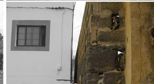
EDIFICACIÓN EXISTENTE CON MURO PALOMERO
