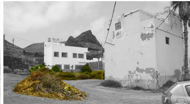
VEGETACIÓN Y ESCOMBROS
