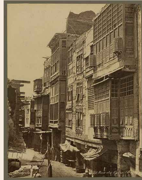
Una calle residencial en el histórico Cairo bordeada de casas con balcones mashrabiya ;fotografía del siglo XIX.
