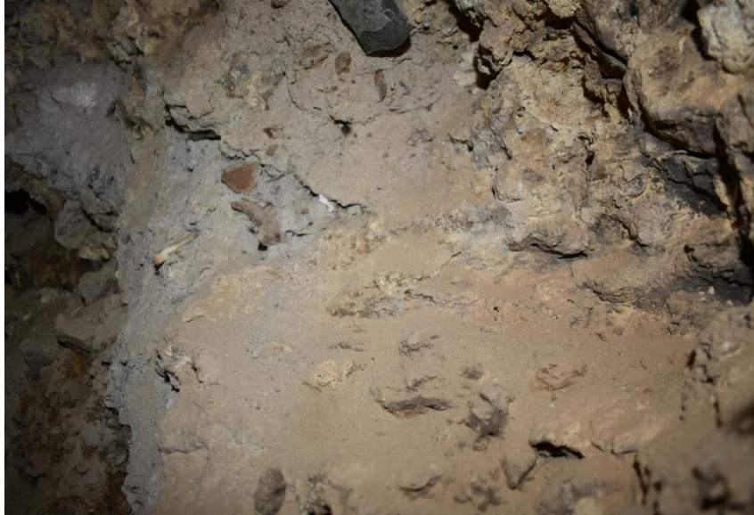
Figura 86: Enlucido con argamasas y materiales insertos en el fondo del Silo 10
