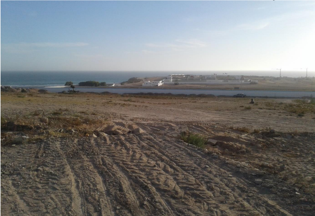
Cliché 1 : travaux de construction de la station de dessalement d'eau de mer de Cap Ghir
