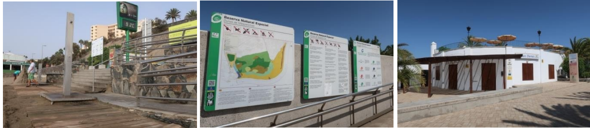
Figura 5. Algunos ejemplos de las deficiencias detectadas en Maspalomas. Izquierda: escalones aislados en itinerarios "adaptados". Centro: cartelera existente en el Mirador de las Dunas de Maspalomas. Derecha: Centro de Interpretación de las Dunas de Maspalomas actualmente cerrado.
