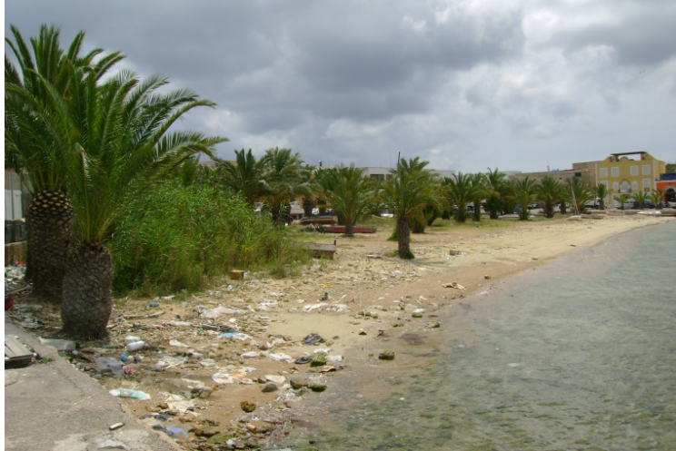
Foto 2: Playa del Puerto Viejo en mayo antes de los trabajos de limpieza.
