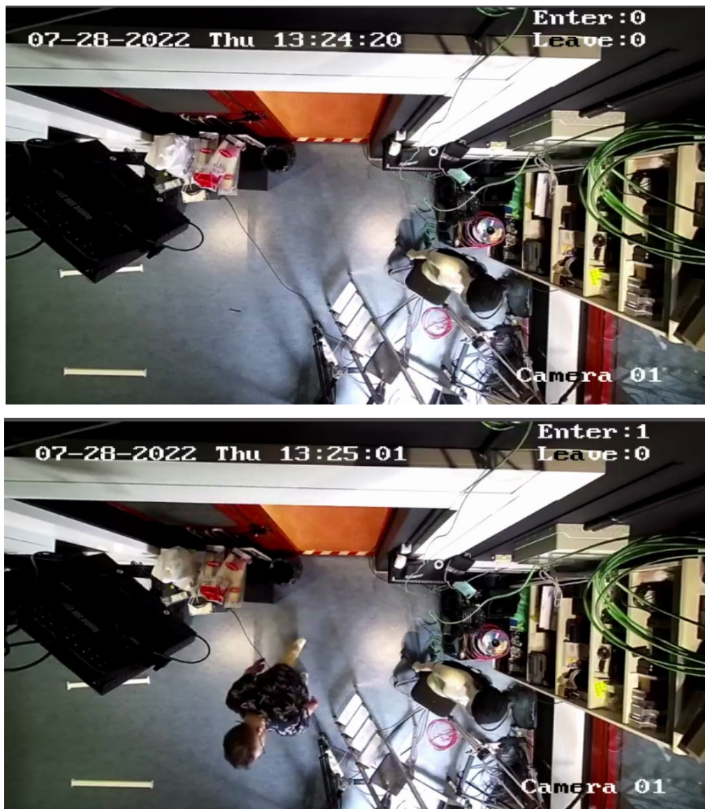
Figura 66. Vista instalación de la cámara de conteo Fuente: Elaboración propia
