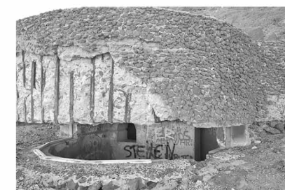
Estado actual de la trinchera y estación telemétrica.
