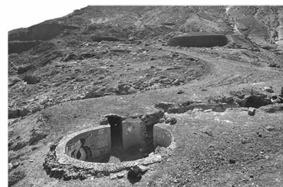
Estado actual de las galerías y baterías.
