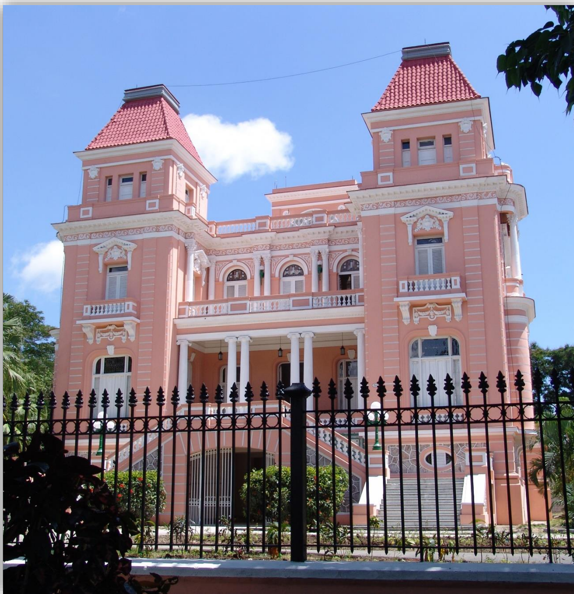
Fotografía 6.73: edificio notable ecléctico, con dominancia neoclásica, en el Reparto Vista Alegre (al noreste del casco histórico). Ciudad de Santiago de Cuba. Captura del 7 de abril de 2007.
