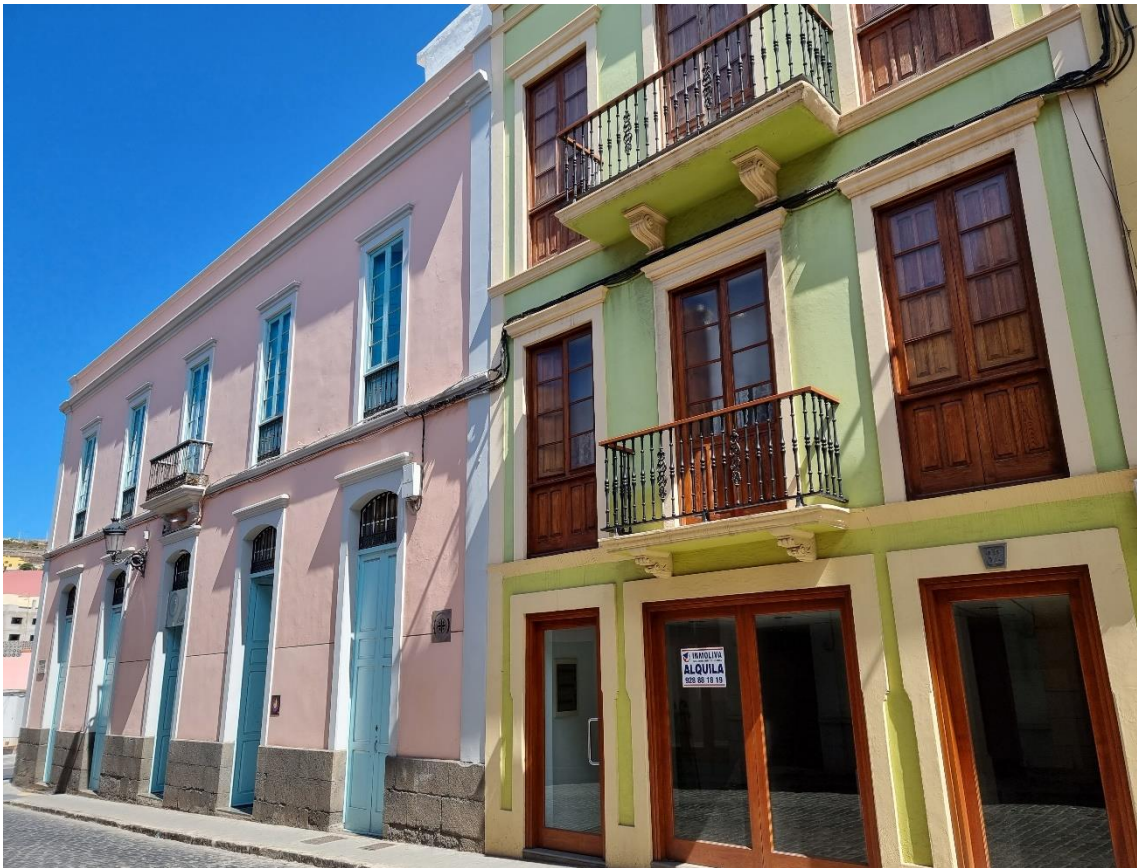
Fotografías 5.40 y 5.41: casona esquinera entre las calles Médico Estévez y Marqués del Muni. Fue construida en 1905-1906. Su tipología edificatoria externa es ecléctica. En sus bajos, se encontraba la original tienda de Santiaguito Gil (de Chago), en donde se podía adquirir el queso de Flor de Guía. Actualmente, el edificio se encuentra restaurado y sus bajos mantiene su habilitación inicial. Captura del 10 de agosto de 2021.
