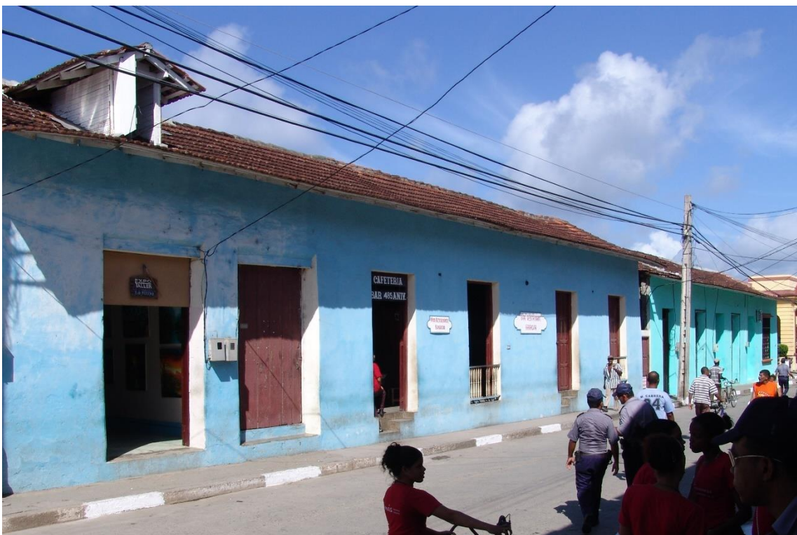
Fotografía 6.33: buhardilla, como ocurre en otras muchas casas, sobre una cubierta de tejas francesas, en la Ciudad de Baracoa. Captura del 18 de julio de 2007.
