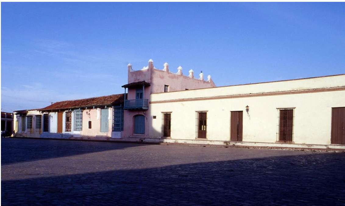
Fotografías 6.99 y 6.100: Plaza San Juan de Dios, en pleno casco histórico de la Ciudad de Camagüey. Muchas de sus edificaciones tienen cubiertas con tejas criollas. Capturas de agosto de 1999.
