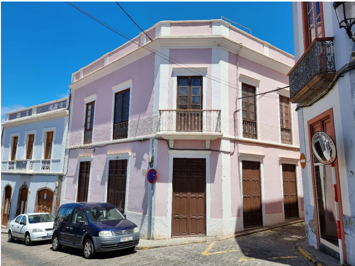
Fotografía 5.57: uno de los edificios (el de la tienda, ya cerrada, de Santiaguito el Cartero ), que da entrada al Callejón de León, desde la Calle Luís Suárez Galván. Captura del 12 de agosto de 2021.
