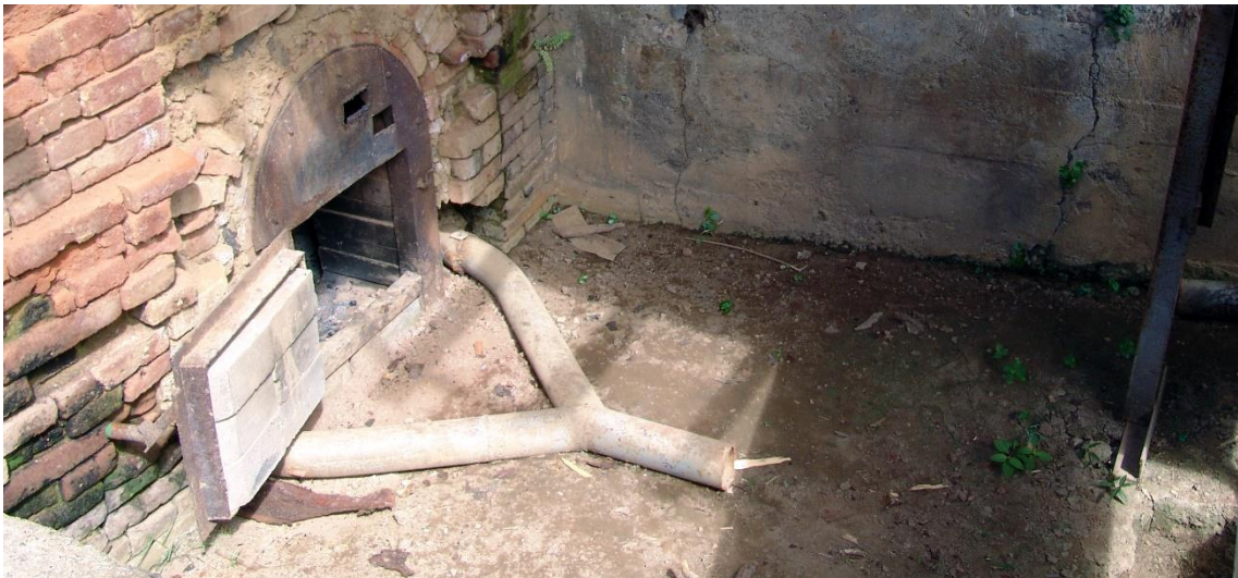
Fotografías 7.21 y 7.22: Fábrica de la Cerámica Roja (Baracoa, Cuba). Horno de oxidación, alimentado por leña, y con el respiradero (hueco para inyectar aire) en un lateral, cargado con ladrillos para guisarlos. Capturas del 19 de julio de 2007.
