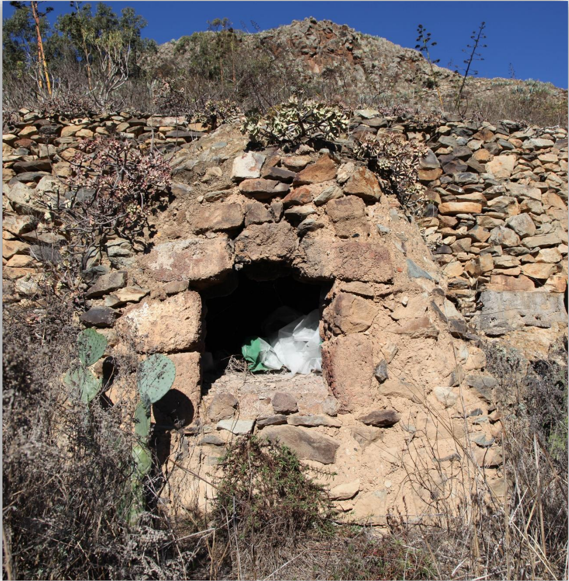
Fotografía 3.66: uno de los hornos de la alfarería de doña Julianita Suárez Vega (Hoya de Pineda), en su estado actual. Se trata de un horno de reducción (crea un ambiente reductor, rico en monóxido de carbono). Se construyó con bloques de piedras volcánicas diversas y barro. Captura del 1 de noviembre de 2021.
