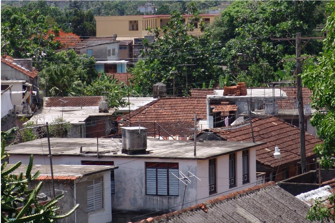
Fotografía 6.36: tejados con tejas francesas, en la Ciudad de Baracoa. Se observa acopios de esta variedad de tejas para reparaciones Captura del 16 de julio de 2007.
