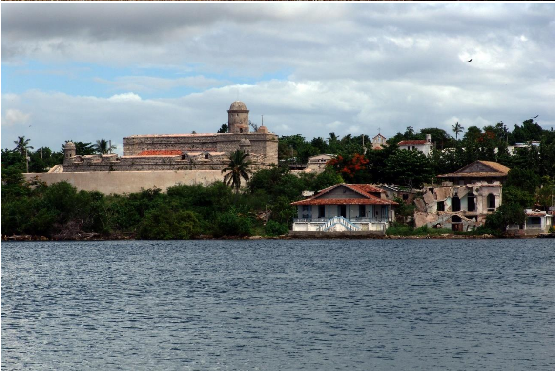
Fotografías 6.133 y 6.134: dominio de la teja francesa, que desplazó significativamente a la criolla, en los alrededores de la Fortaleza de Jagua, por la herencia cultural de los colonos franceses, fundadores de Cienfuegos en 1819, a iniciativa de la Corona de España. Capturas del 6 de agosto de 2006.
