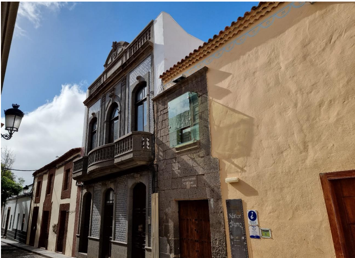
Fotografía 5.31: En el centro de la imagen, casa de don Fernando Bañolas (nº 5 de la Calle San José), de estilo arquitectónico ecléctico. En sus inicios, era de una sola planta, pero, en la primera mitad del siglo XX, se remodeló, y pasó a tener dos plantas. Captura del 7 de agosto de 2021.
