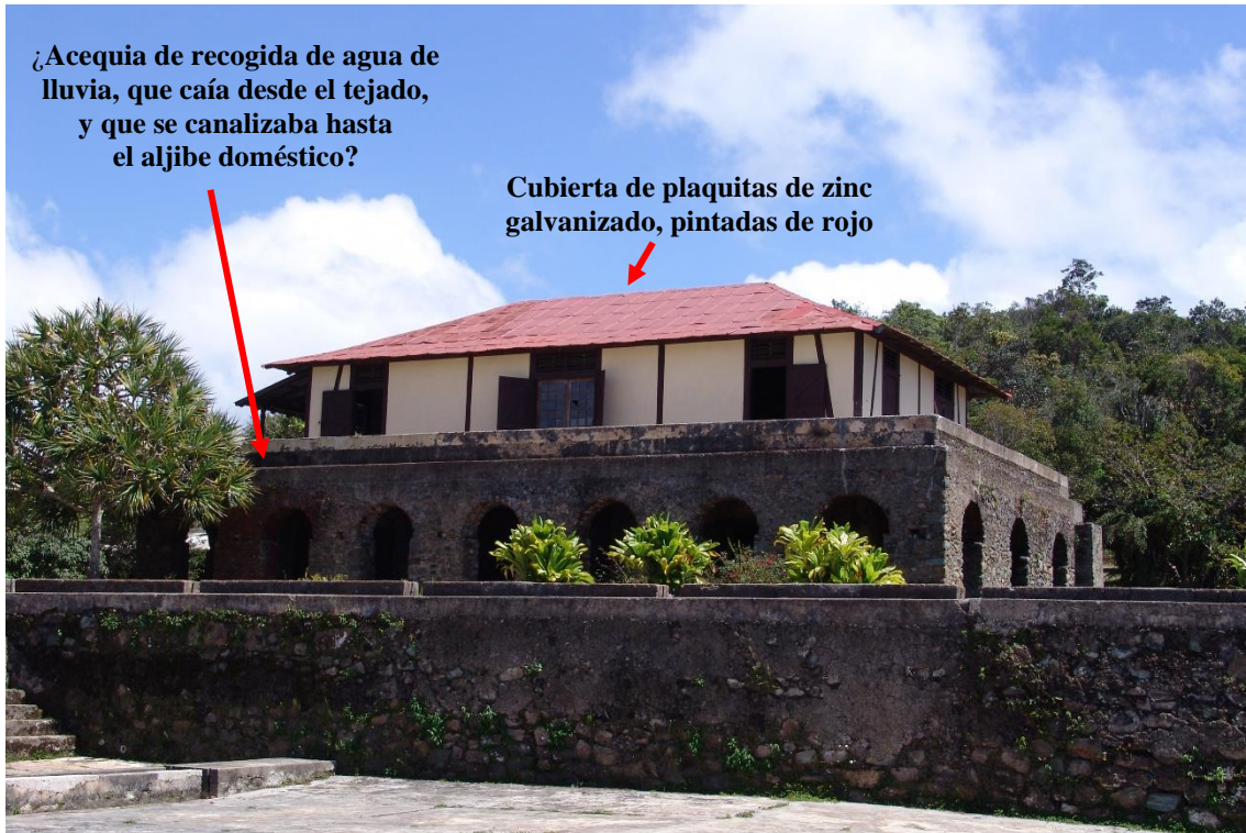
Fotografía 6.90: cubiertas de plaquitas de zinc galvanizado, como alternativa a las tejas francesas, en el Cafetal La Isabelica (La Gran Piedra, Santiago de Cuba). Captura del 16 de marzo de 2007.
