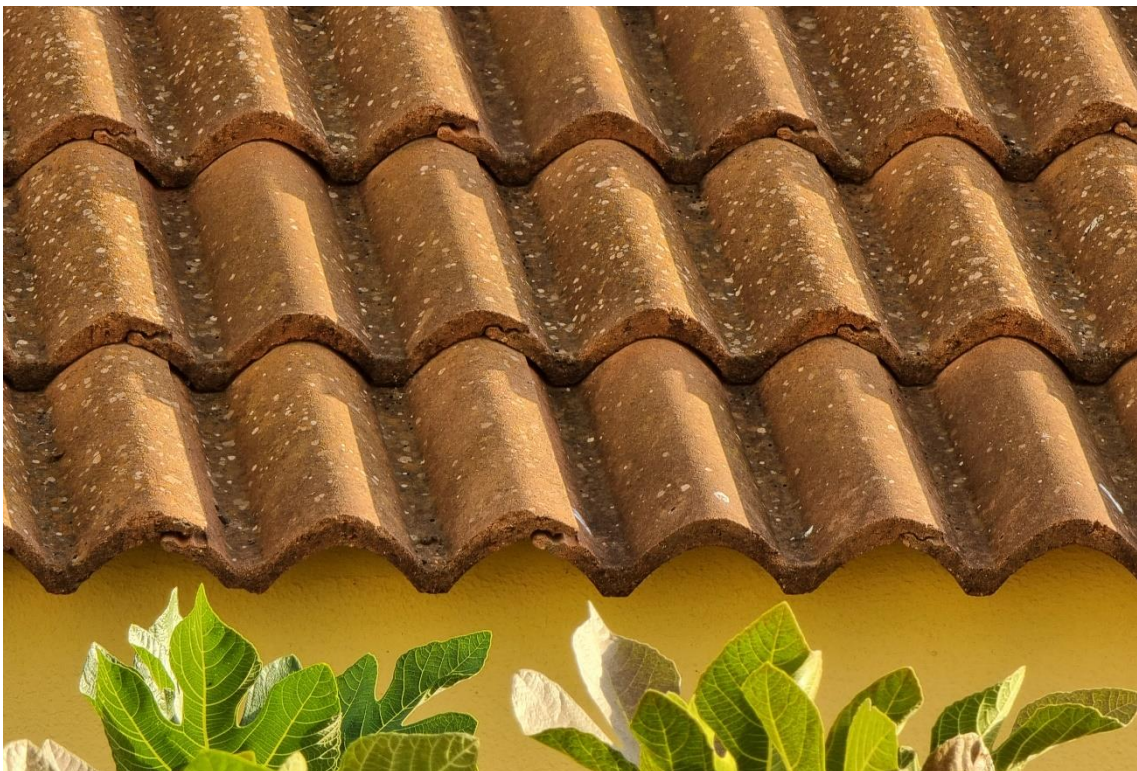
Fotografía 5.59: detalle de la cubierta de planchas de mortero, que imitan la morfología de un tejado de tejas de arcilla. Colegio de Educación Especial Marente. Guía de Gran Canaria. Captura del 1 de agosto de 2021.
