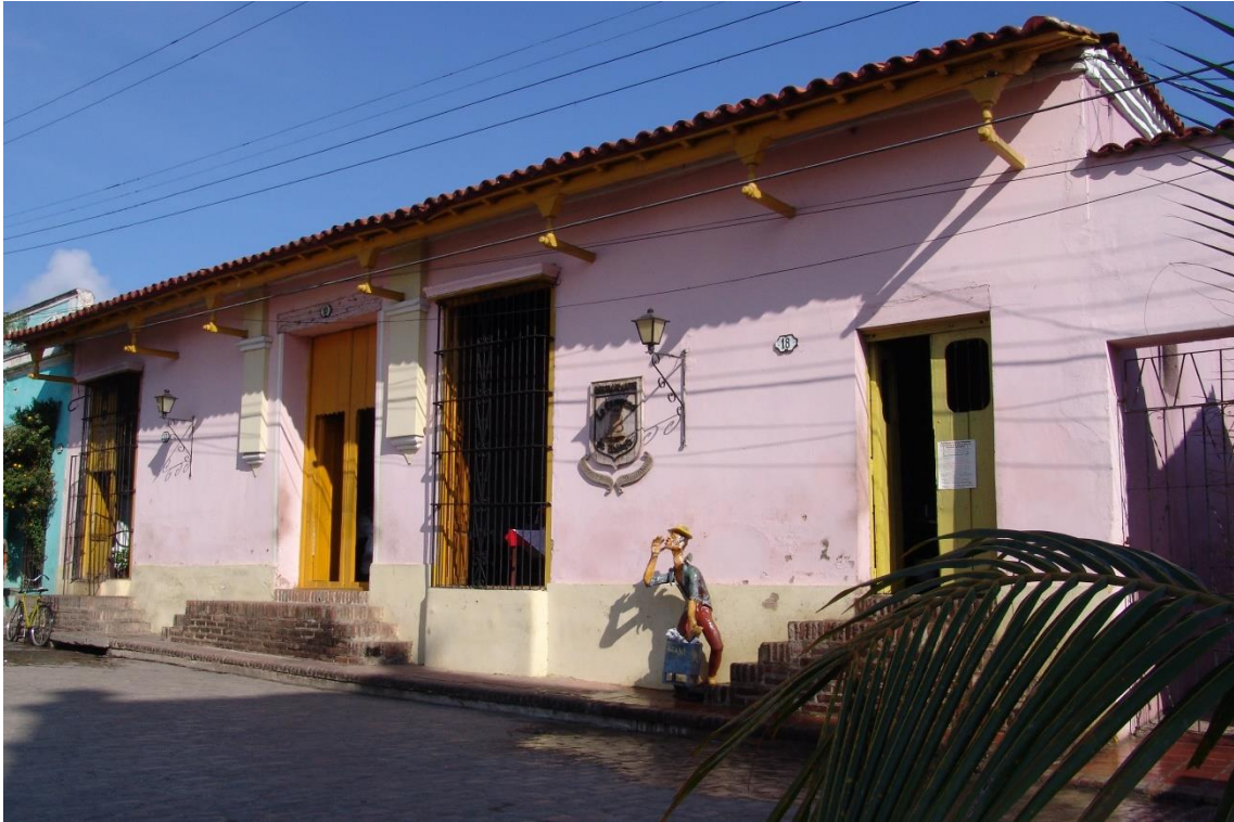
Fotografía 6.105: tipología edificatoria urbana, en el entorno de la Plaza San Juan de Dios (Camagüey). Captura del 30 de diciembre de 2005.
