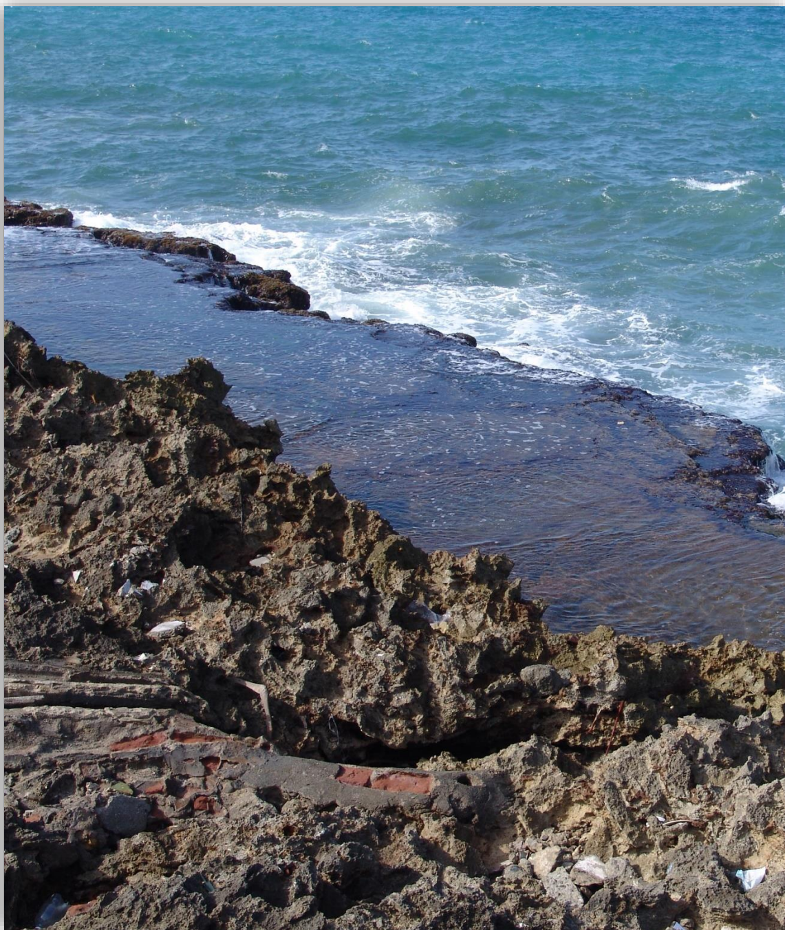
Fotografía 6.13: en un primer plano, al pie del Malecón de Baracoa, hay un emisario de aguas negras, construido con cerámica, a través de una estructura erosiva de dientes de perro , labrada en el techo de una rasa levantada. Captura del 16 de julio de 2007.
