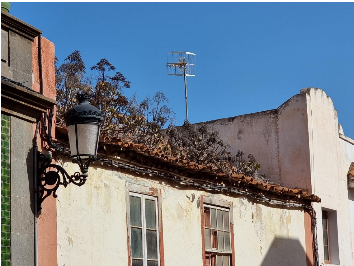
Fotografías 5.20 y 5.21: casa sobria de dos plantas, con vanos de cantería en la planta baja, y con tejado de teja de arcilla, en donde se han desarrollado profusamente jardines silvestres Calle Canónigo Gordillo, nº 21 (Guía de Gran Canaria). Capturas del 22 y del 29 de agosto de 2021 (de arriba abajo).
