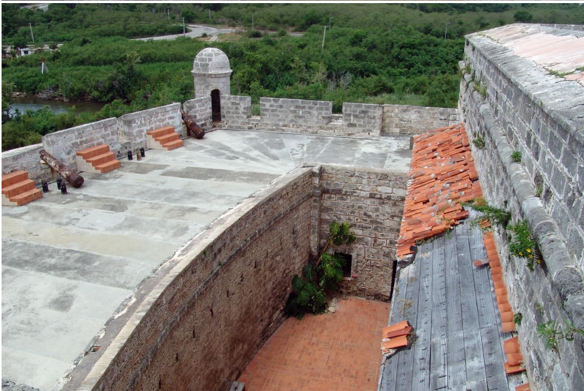
Fotografías 6.131 y 6.132: teja criolla custodiada en el interior de la Fortaleza de Jagua (Cienfuegos. Capturas del 6 de agosto de 2006.
