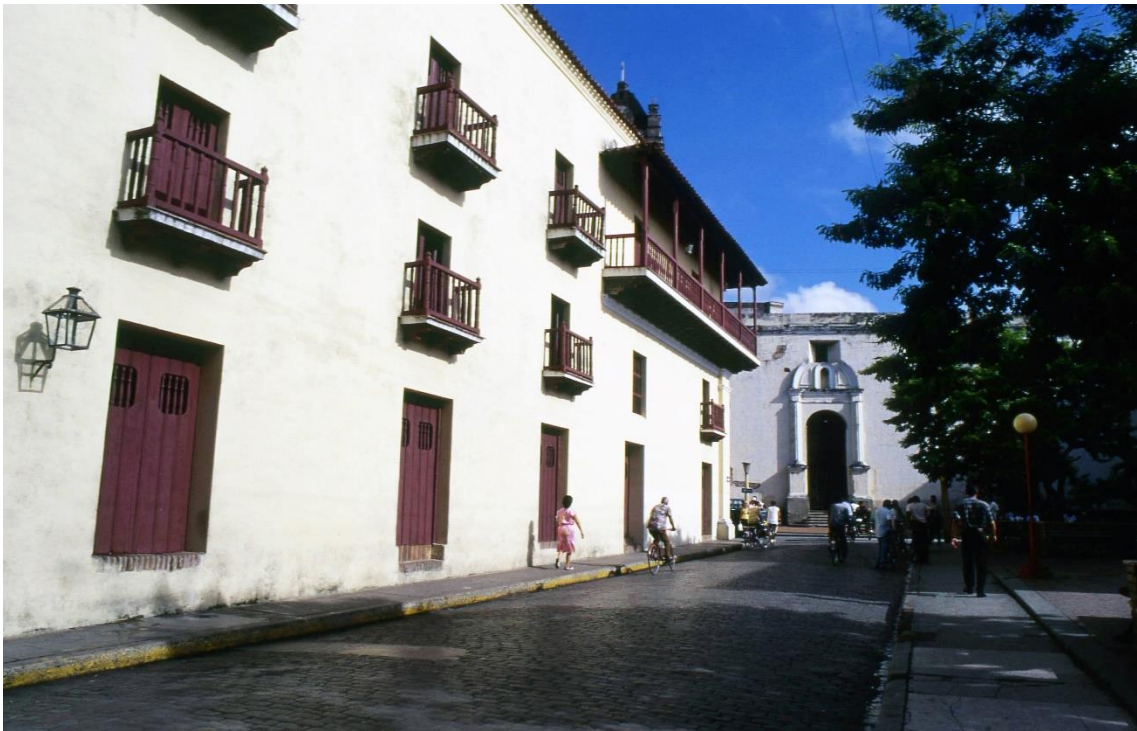
Fotografías 6.109 y 6.110: En la Ciudad de Camagüey puede haber construcciones donde la presencia de la teja criolla destaque poco, por la perspectiva visual. Capturas de agosto de 1999.
