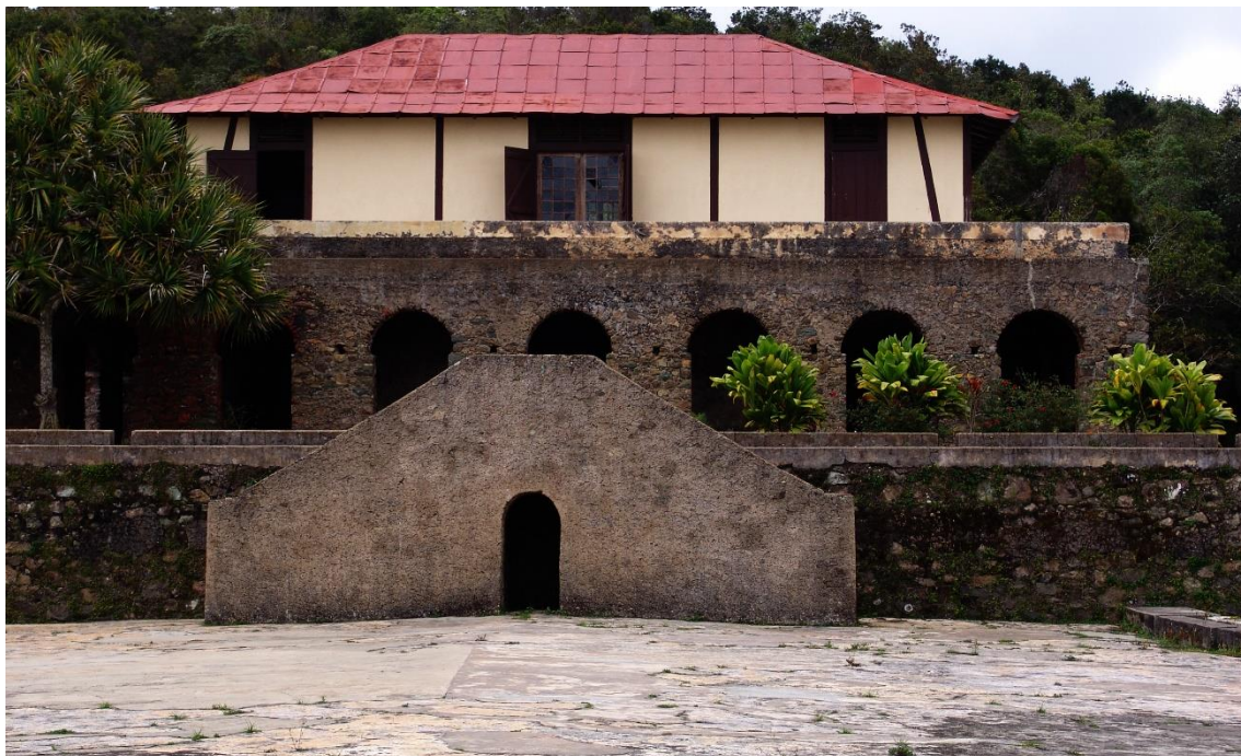
Fotografía 6.91: Cafetal La Isabelica (La Gran Piedra, Santiago de Cuba). En la parte superior de la imagen, detalles de la cubierta con plaquitas de zinc galvanizado. Captura del 16 de marzo de 2007.
