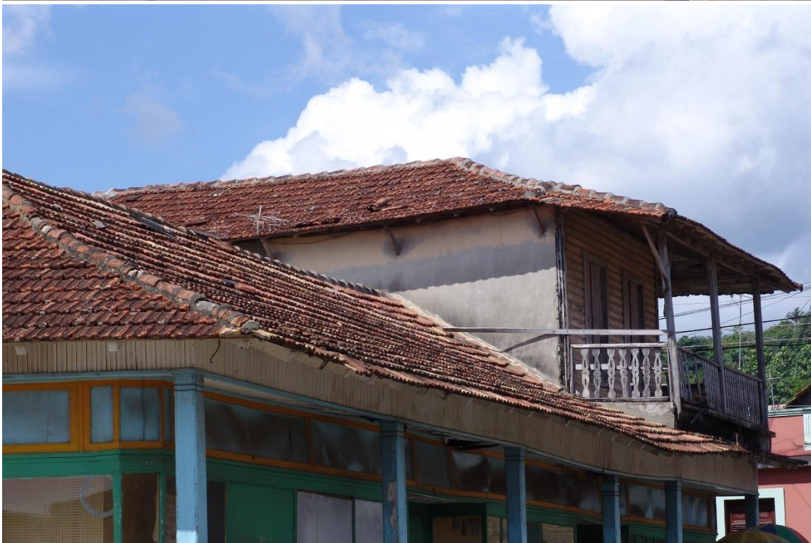
Fotografías 6.24 y 6.25: conjunto de casas con tejados de tejas francesas, en el casco histórico de la Ciudad de Baracoa. Capturas del 16 de julio de 2007.
