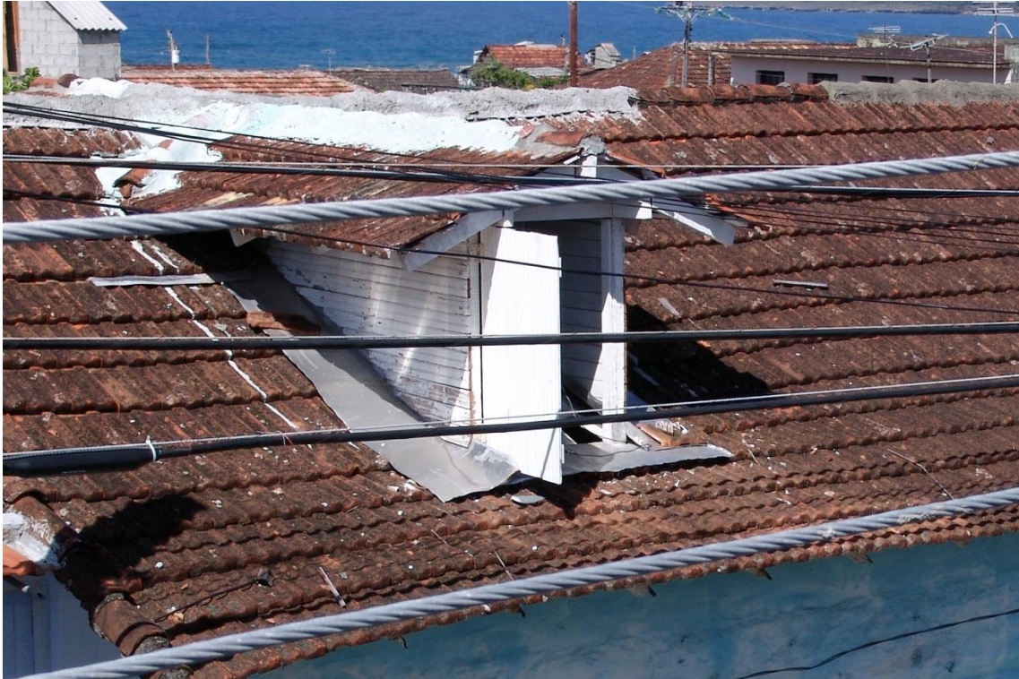
Fotografía 6.21: tipología edificatoria externa de las casas populares del Oriente cubano. Buhardilla sobre un tejado de tejas francesas, en la Calle Antonio Maceo (Baracoa). Captura del 18 de julio de 2007.
