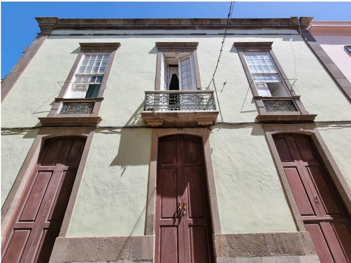
Fotografía 5.27: vista frontal de una casa señorial, de la Calle Canónigo Gordillo, nº 6. La construcción se levantó en la segunda mitad del siglo XIX, y tiene una tipología edificatoria externa ecléctica, con elementos del neoclásico. La cubierta es de tipo azotea. Captura del 22 de agosto de 2021.
