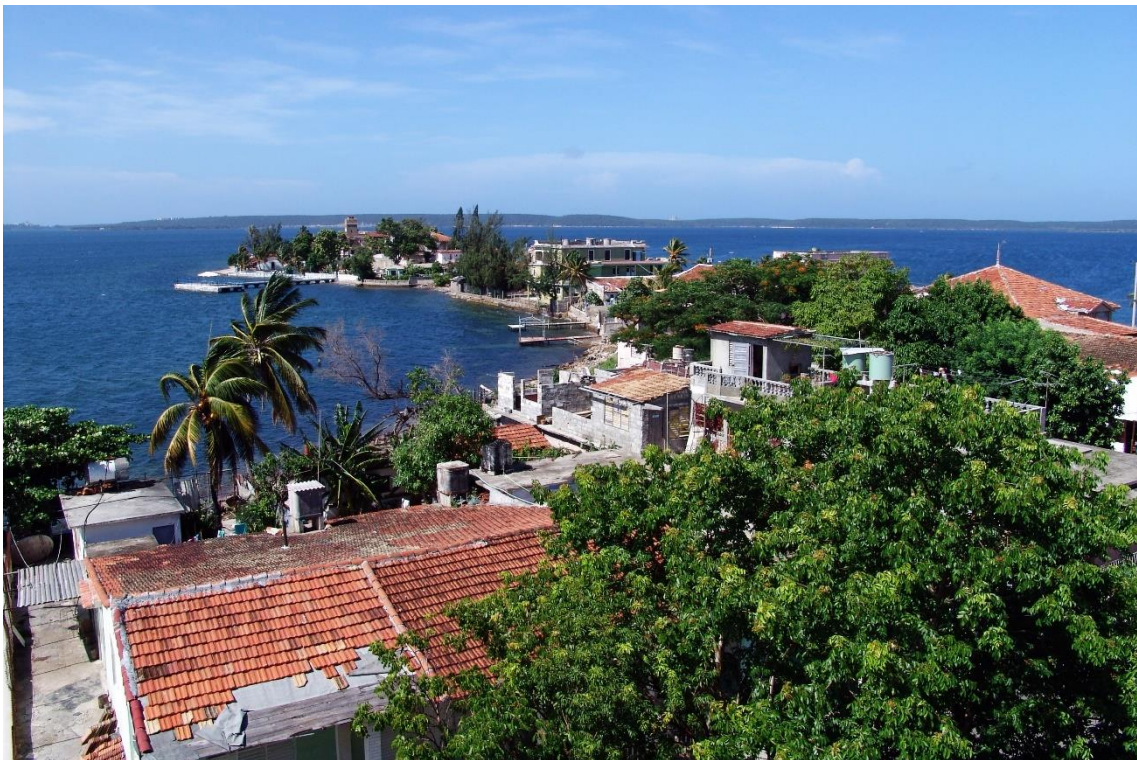
Fotografías 6.135 y 6.136: dominio de la teja francesa, que desplazó significativamente a la criolla, en los alrededores de la Fortaleza de Jagua. Capturas del 6 de agosto de 2006 (superior) y del 7 de agosto de 2006 (inferior).
