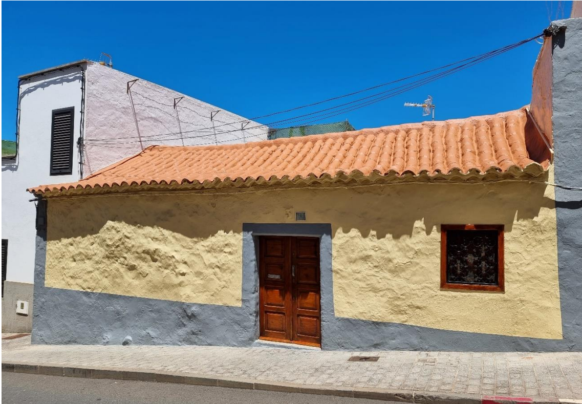
Fotografía 5.8: casa terrera de doña Ilda Bolaños. Calle José Samsó Henríquez, nº 37, en su tramo de la Villa de Arriba (Guía de Gran Canaria). El tejado de tejas está sin su jardín silvestre , quizás por un mantenimiento de la cubierta presuntamente desnaturalizante respecto a la vegetación espontánea. Captura del 8 de agosto de 2021.
