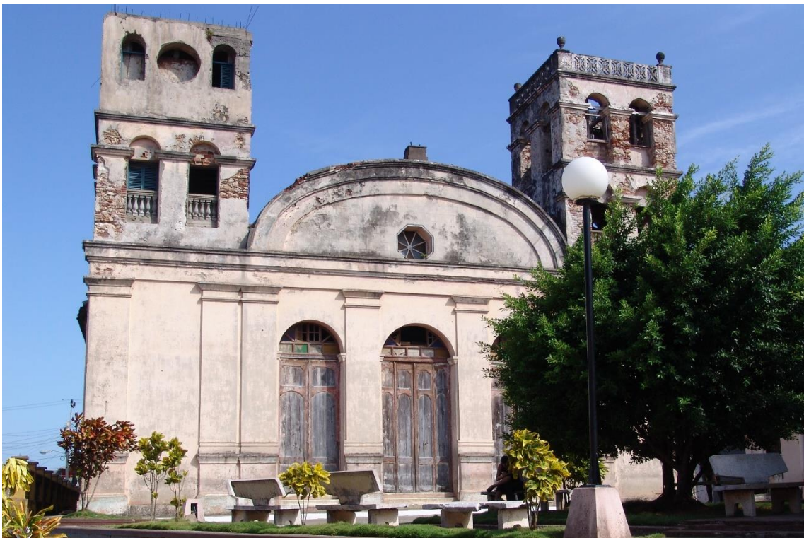
Fotografías 6.17 y 6.18: Iglesia de la Parroquia de Nuestra Señora de la Asunción, reconvertida en Basílica Menor, por el Vaticano, en 2013, dentro del casco de Baracoa. Se construyó en 1807, con sucesivas transformaciones hasta 1905. Su última restauración tuvo lugar en 2009. Sus muros basales se levantaron con bloques de piedras. Pero sus torres se edificaron con la utilización de ladrillos de arcilla. Capturas del 18 y 16 de julio de 2007 (de arriba a abajo).
