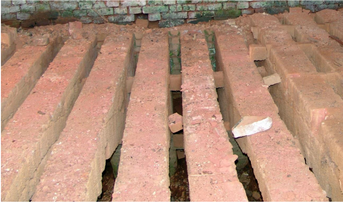
Fotografía 7.25: Fábrica de la Cerámica Roja (Baracoa, Cuba). Interior de la cámara de guisado, de un horno de oxidación, alimentado por leña, que estaba en desuso temporal. En la parte inferior, bajo la superficie que soporta la carga de piezas a guisar, se encuentra la cámara respiradero, que recibe, durante el guisado, el aire inyectado desde el exterior, a través de una tubería bifurcada y conectada a un motor. Captura del 19 de julio de 2007.
