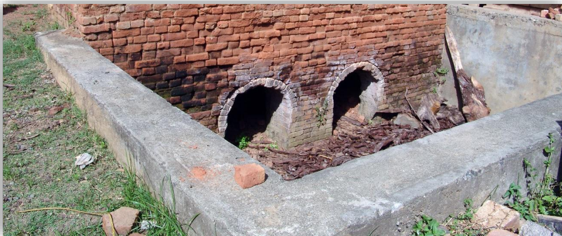
Fotografías 7.23 y 7.24: Fábrica de la Cerámica Roja (Baracoa, Cuba). Horno de oxidación, alimentado por leña, y con el respiradero (hueco para inyectar aire) en un lateral, en desuso temporal. Capturas del 19 de julio de 2007.
