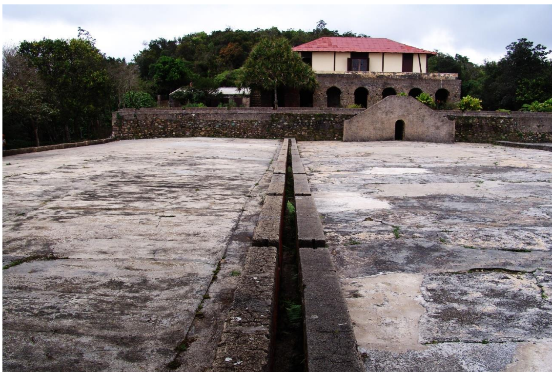
Fotografía 6.89: casa principal del Cafetal La Isabelica (La Gran Piedra, Santiago de Cuba), con una planta superior para el dueño, y con un basamento de dependencias industriales y de servicios. En un primer plano, los secaderos de la plantación. Captura del 16 de marzo de 2007.
