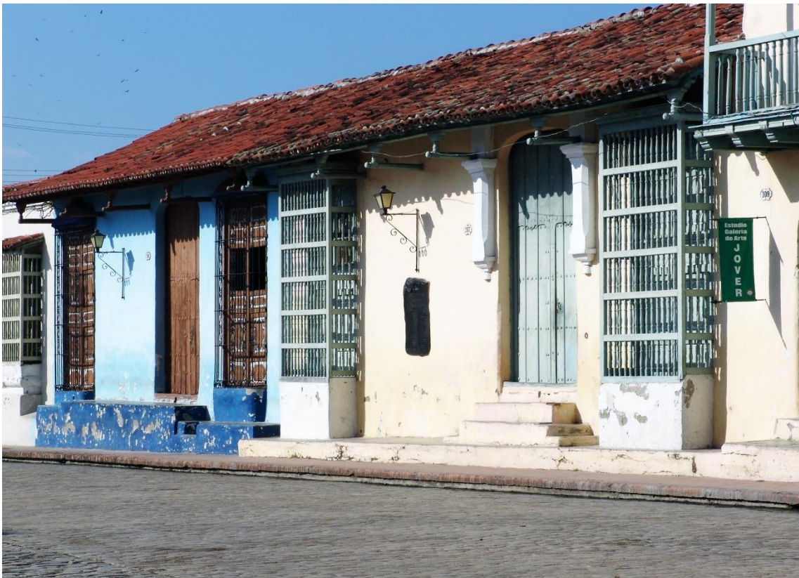
Fotografía 6.102: tipología edificatoria urbana, en el entorno de la Plaza San Juan de Dios (Camagüey). Captura del 30 de diciembre de 2005.
