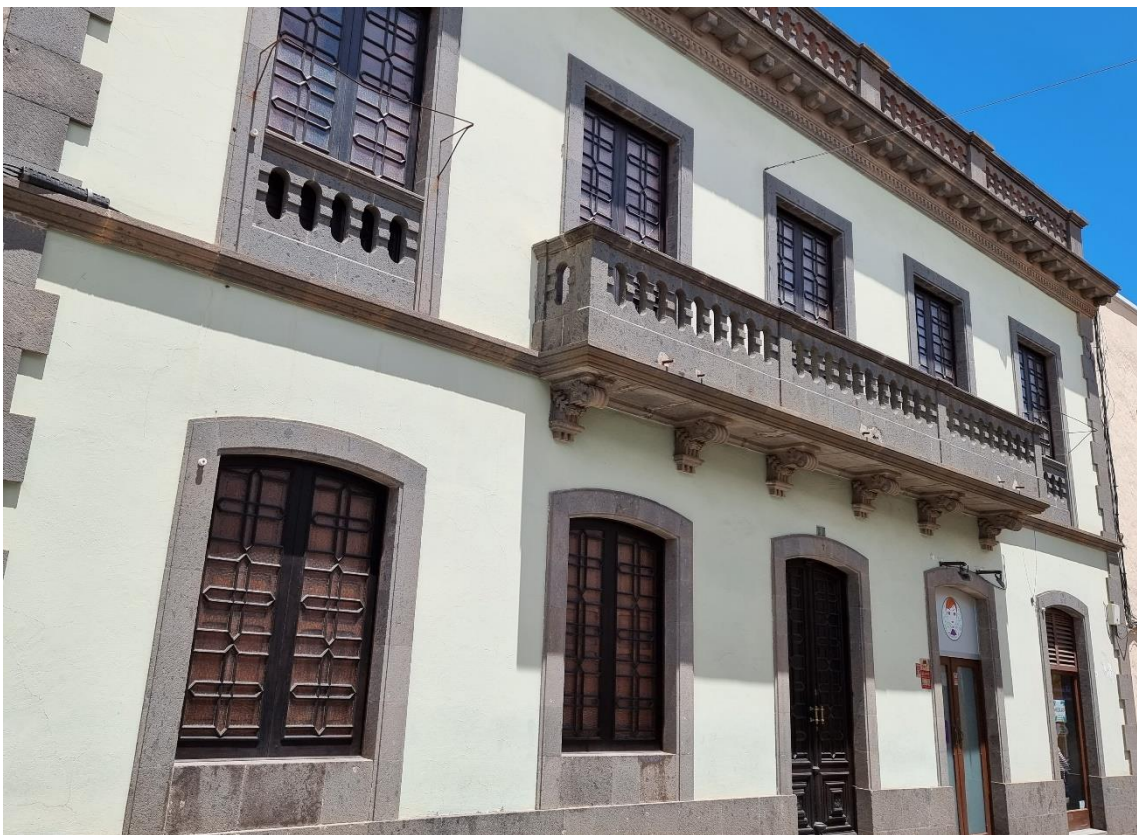
Fotografías 5.33 y 5.34: casa señorial en la Calle Médico Estévez, nº 3. Se construyó en la primera mitad del siglo XIX. En la fachada, destaca el empleo de la cantería en la decoración. Tipología edificatoria externa ecléctica. Captura del 10 de agosto de 2021.
