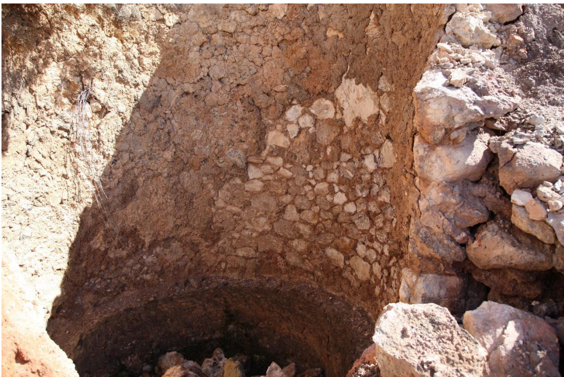
Fotografía 5.65: vista parcial del interior de la Calera de la Palmera, en la periferia de Huebro (Níjar). Destaca el bordillo que servía para apoyar el primer anillo (el más externo) de la cúpula que soportaba la carga de piedras calizas en el horno de cal. Captura del 3 de mayo de 2017
