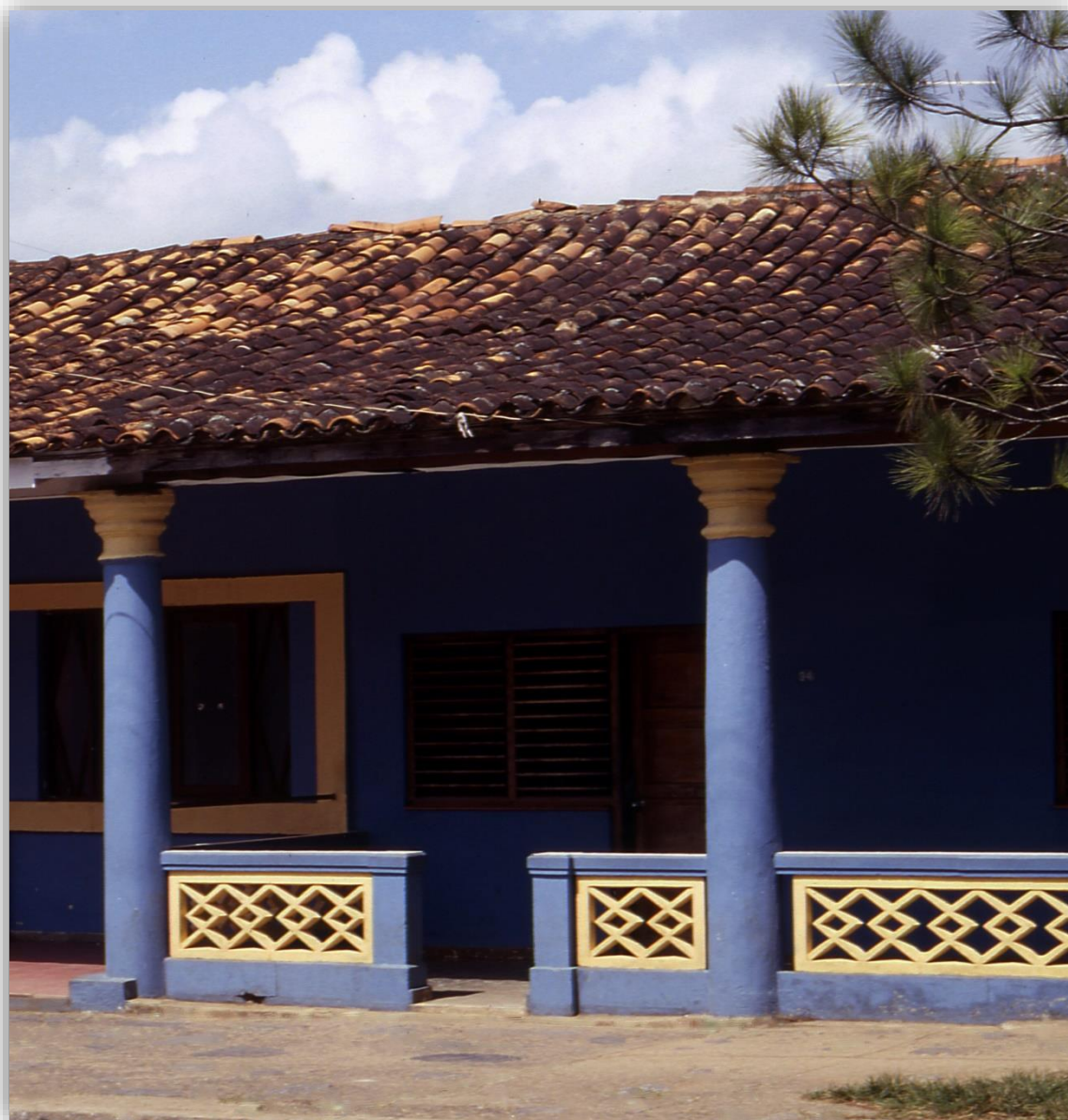
Fotografía 6.172: casa popular en la población de Viñales (Cuba), con una tipología edificatoria externa, que muestra dos de los rasgos más identitarios de las construcciones locales: cubierta de tejas criollas y soportales con columnas cilíndricas. Captura del 5 de abril de 1997.
