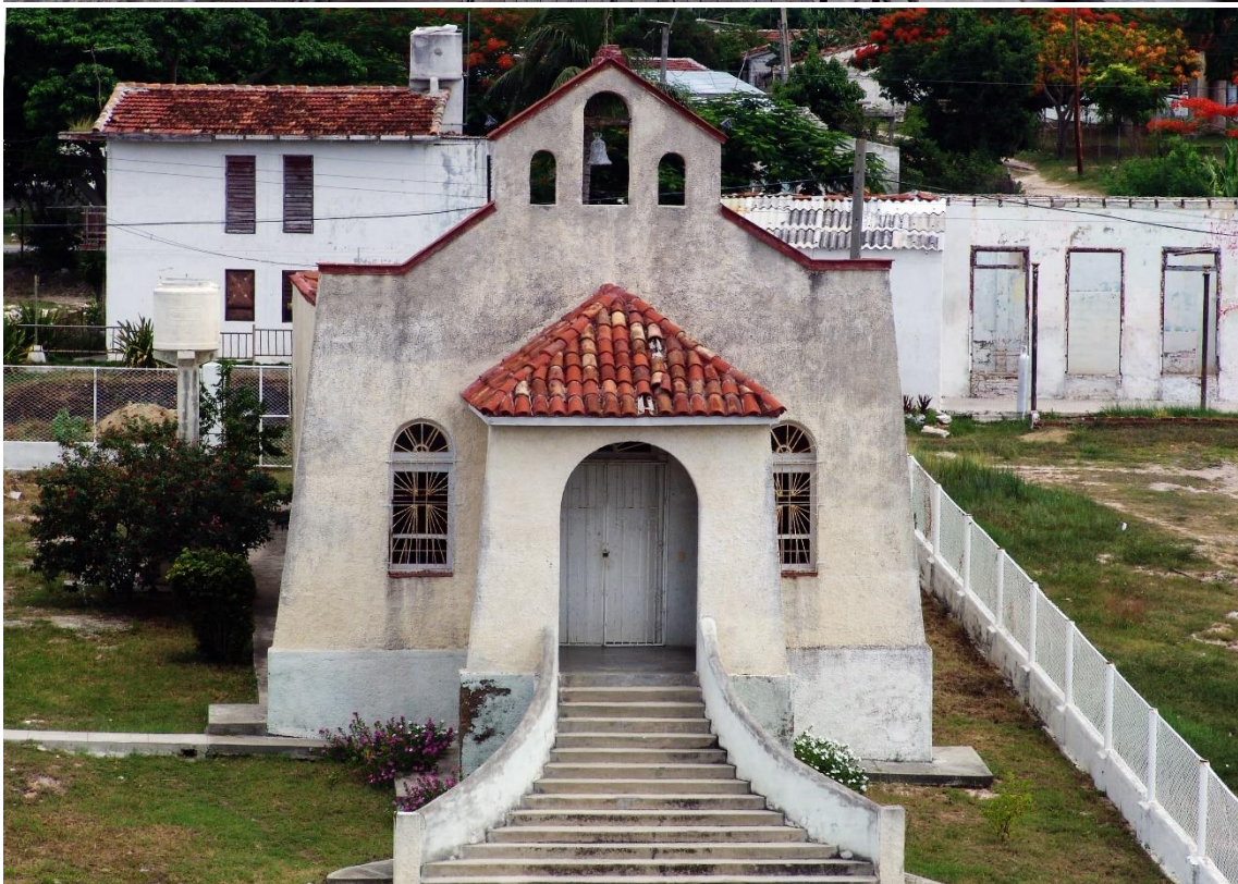
Fotografías 6.137 y 6.138: dominio de la teja francesa, en los alrededores de la Fortaleza de Jagua, aunque la teja criolla, en algunas ocasiones, resistió a su desplazamiento. Capturas del 6 de agosto de 2006.
