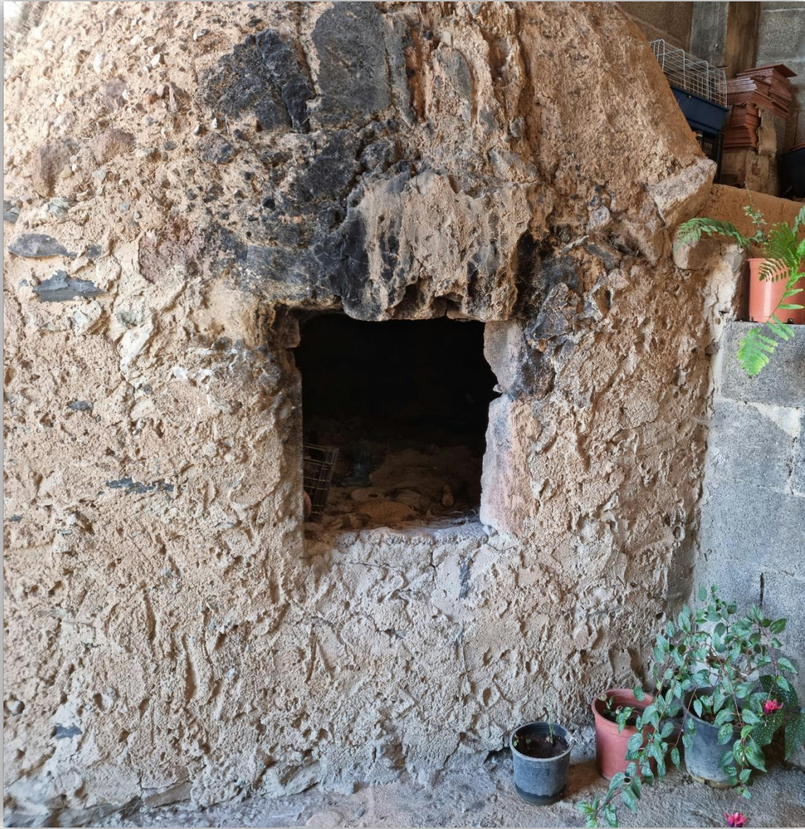
Fotografía 3.67: uno de los hornos de la alfarería de doña Julianita Suárez Vega (Hoya de Pineda). En una de las reparaciones del horno hechas por un hijo de la alfarera, los bloques de piedra y el mortero de barro, de la construcción original, fueron recubiertos por mezcla (mortero de cemento, arena y aditivos, empleado en la construcción). Captura del 30 de octubre de 2021.
