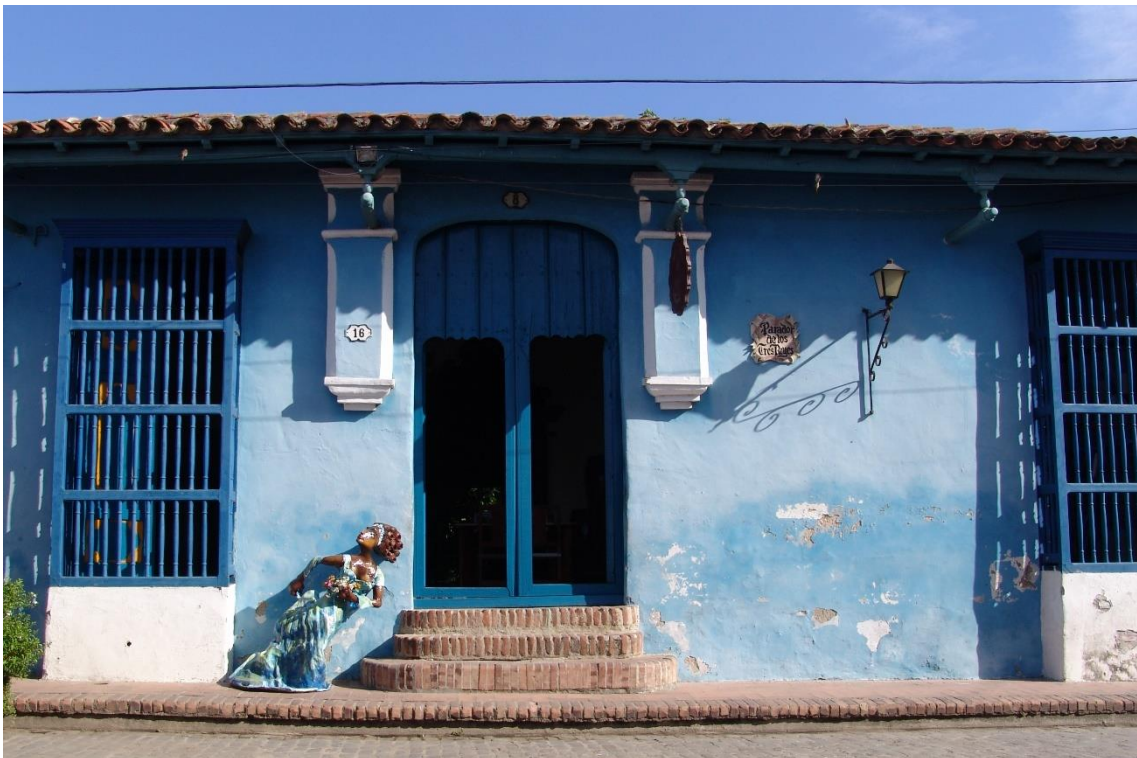
Fotografía 6.104: Ciudad de Camagüey. Tipología edificatoria externa de una de las casas que delimitan la Plaza San Juan de Dios. Captura del 30 de diciembre de 2005.
