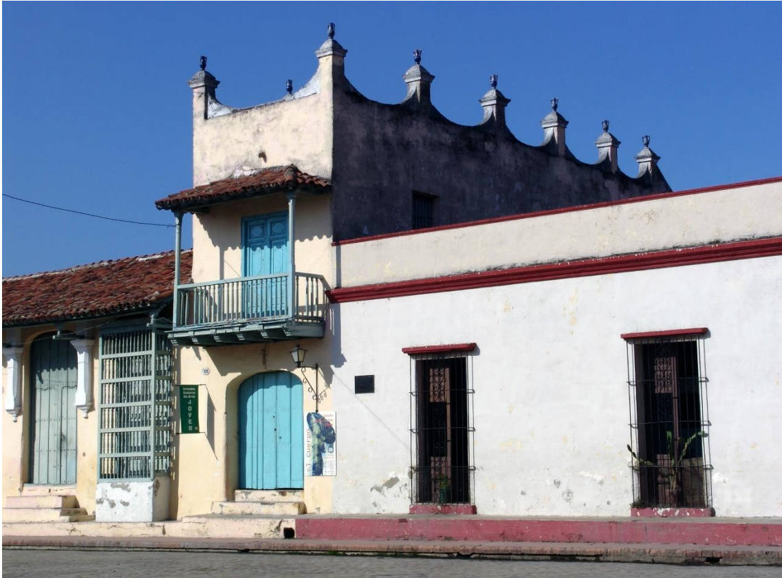
Fotografía 6.101: tipología edificatoria urbana, en el entorno de la Plaza San Juan de Dios (Camagüey). Captura del 30 de diciembre de 2005.
