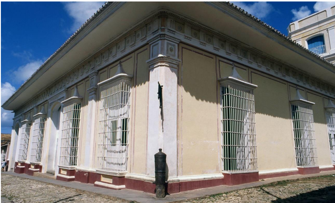
Fotografía 6.122: casas que utilizan la teja criolla en su tipología edificatoria externa. Los ventanales son representativos del lugar. Ciudad de Trinidad. Captura del 20 de agosto de1997.
