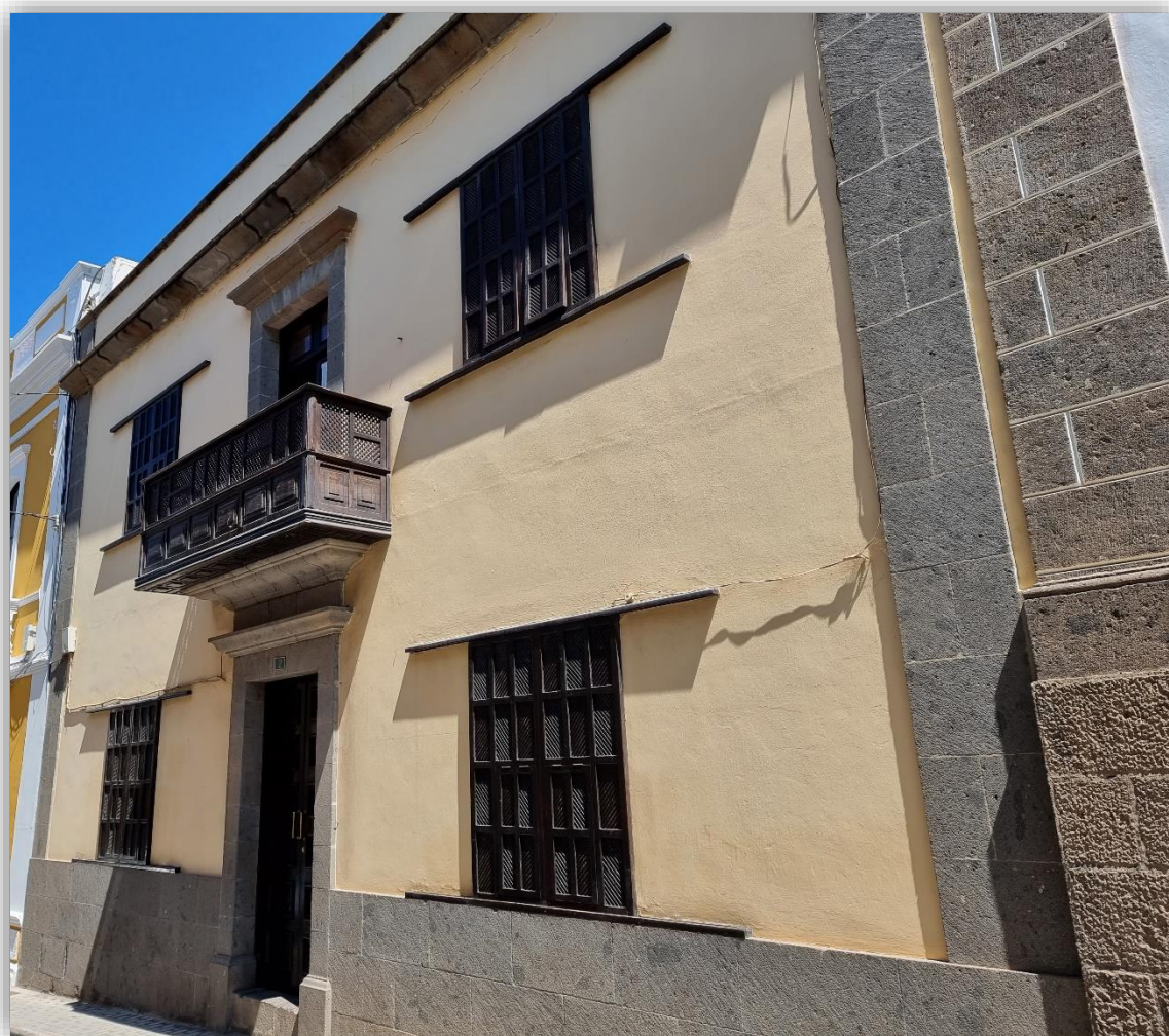
Fotografía 5.32: casa señorial en la Calle Médico Estévez, nº 2. Se construyó en el siglo XIX. Su fachada fue remodelada a mediados del siglo XX. Con la remodelación, quedó afectada la tipología edificatoria externa, de la fachada, que introdujo un balcón descubierto mudéjar y ventanas rectangulares en celosía. Captura del 10 de agosto de 2021.
