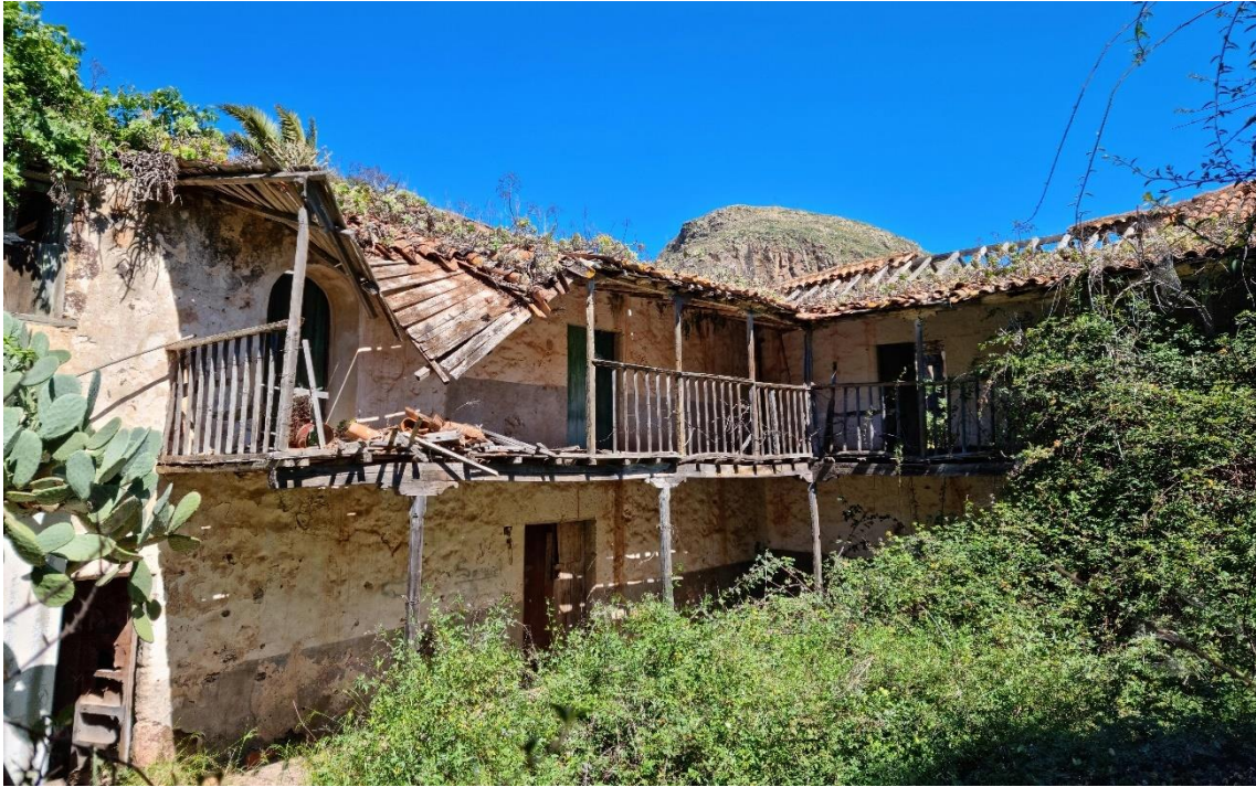
Fotografía 3.20: vista de una parte de la fachada principal, que rodea a un patio central abierto, desde una perspectiva que permite observar las cubiertas. Captura del 9 de abril de 2022.
