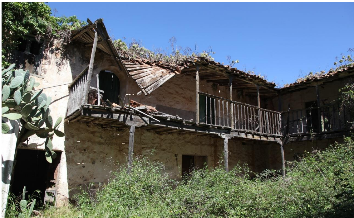
Fotografía 3.19: vista parcial de la fachada principal, que rodea a un patio central, de la Casona de los Pineda. Captura del 9 de abril de 2022.
