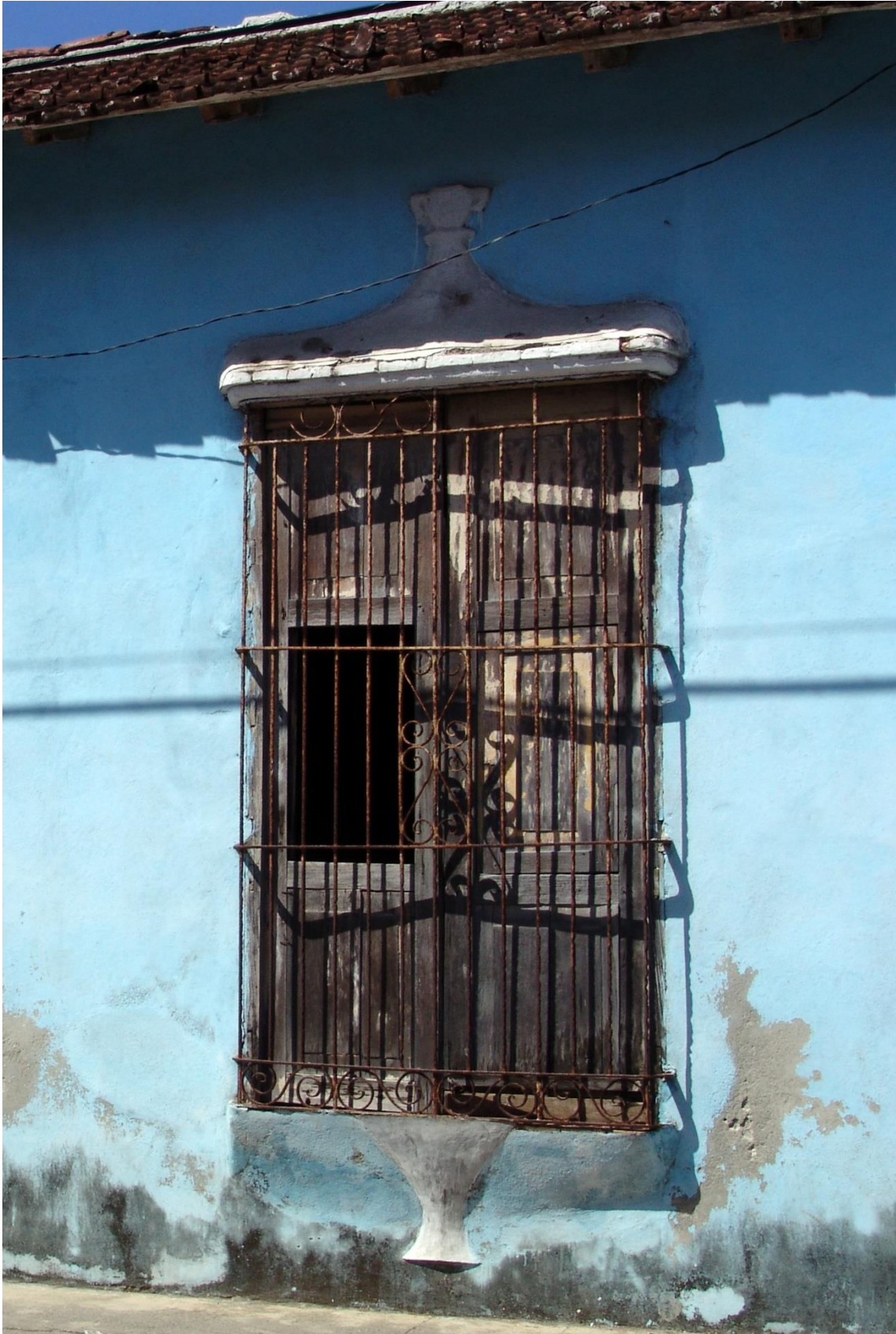
Fotografía 6.23: tipología edificatoria externa de las casas populares del Oriente cubano. Casa del Historiador de la Ciudad de Baracoa (una de las casas más antiguas del núcleo urbano, levantada en el siglo XIX, y ubicada en la Calle Antonio Maceo). Detalle de uno de los ventanales de la fachada, con sus ménsulas y bota aguas. Captura del 18 de julio de 2007.
