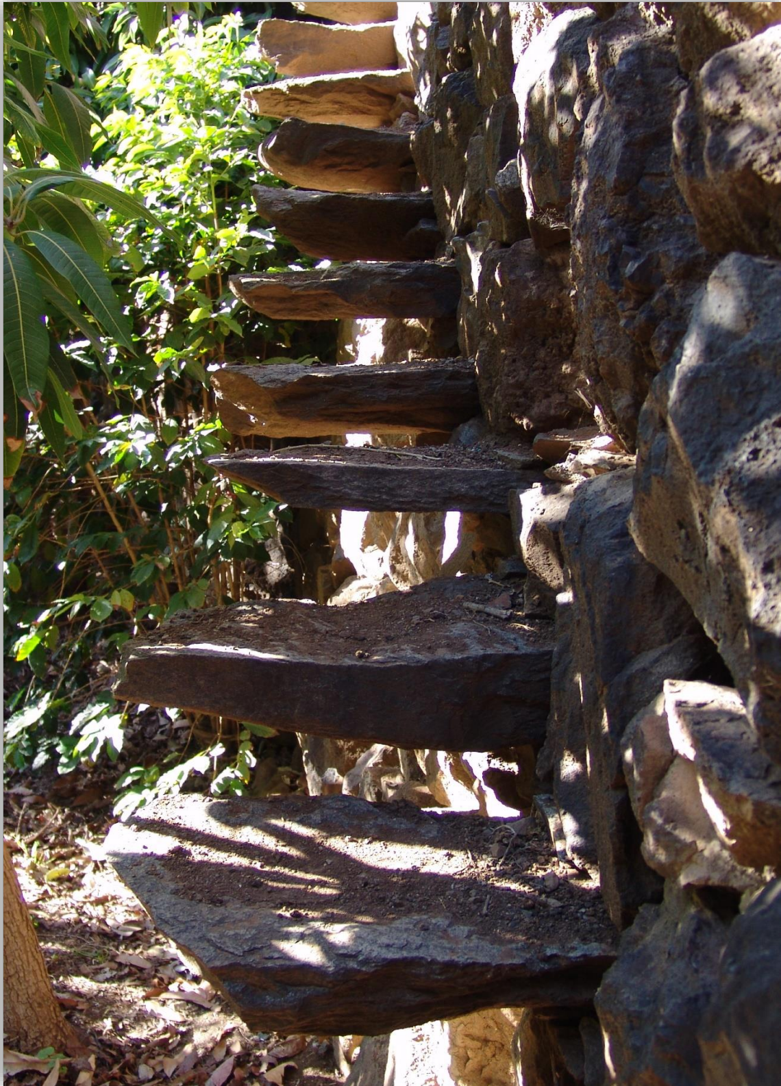
fotografía 5.66: peldaños de las escaleras formada por el anclaje de lajas de roca, en uno de los muros construidos con bloques de piedra, entre bancales de la Finca El Vínculo y Solana (Valle de Agaete, Gran Canaria). Estos peldaños recuerdan a los de las escaleras en caracol, que daban acceso a las puertas laterales de las cámaras superiores (de guisado), en los hornos alfareros de tejas y ladrillos, en la comarca septentrional de la isla de Gran Canaria. Captura del 23 de abril de 2008.
