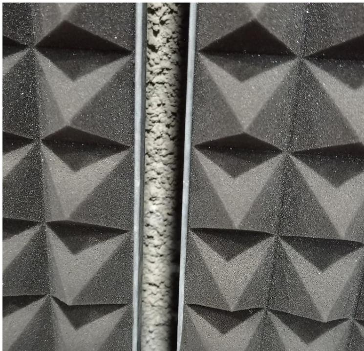
Figura 34. Waffel instalado en las paredes posteriores del Paraninfo
