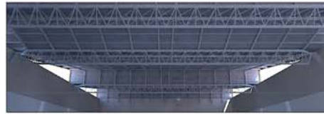
VISTA DEL ENTRAMADO ESTRUCTURAL DE LA CUBIERTA
