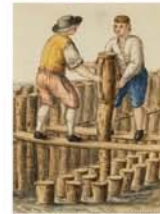
METODO ANTIGUO DE HINCAMIENTO
