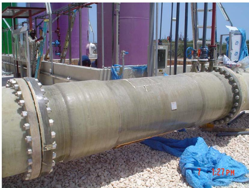
Figura 10. Tubería de captación de agua de mar. [30]
