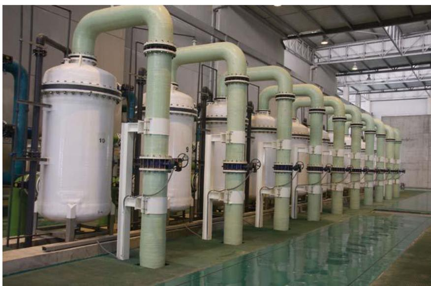
Figura 12. Disposición de los filtros de cartucho. [31]
