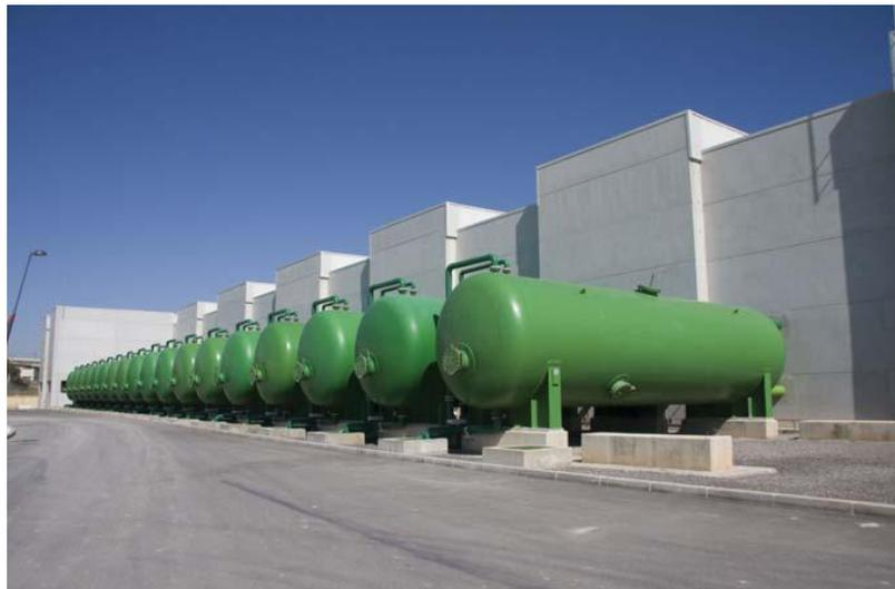
Figura 11. Disposición de los filtros de arena. [31]
