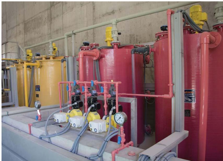
Figura 13. Depósitos para dosificar los productos químicos. [31]
