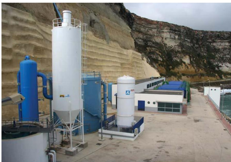
Figura 31. Depósitos de reactivos para el postratamiento. [34]
