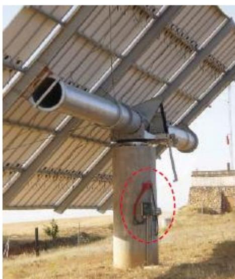
Figura 47. Caja de conexiones de un módulo fotovoltaico. Fuente: Ramírez, 2008.
