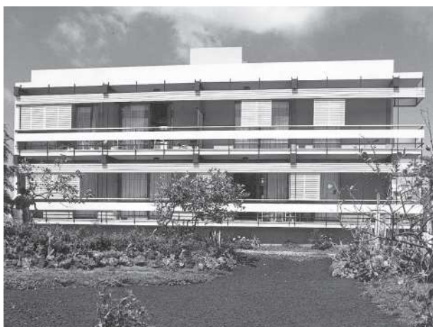
Edificio de apartamentos fachada poniente, fotografía de Fachico Rojas. 5
