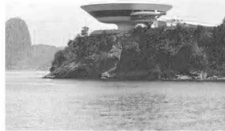
Museo de Arte Contemporáneo de Nitrói. (1996) Arquitectos: Oscar Niemeyer. Objeto con forma de copa o de flor que se abre hacia al cielo. En la estructura se distingue la parte enterrada, el apoyo central y sobre éste el cuerpo principal.
