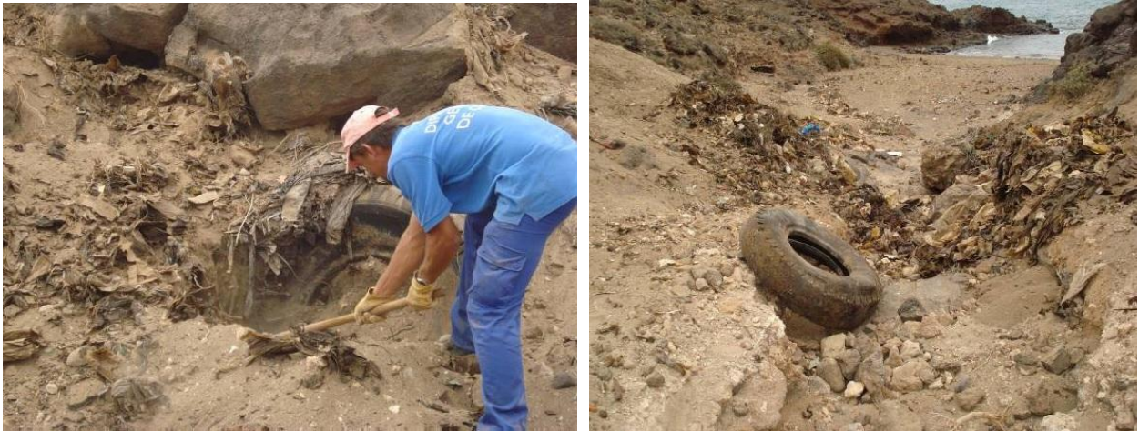
Figura 5.23. Limpieza del litoral realizada por TRAGSA en 2008 en el marco del proyecto “Mantenimiento y Conservación de Costas” (Demarcación de Costas de Canarias). Fotografías facilitadas por TRAGSA.
