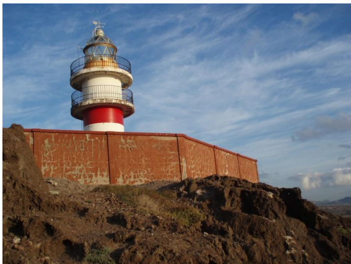
Figura 5.26. Muro que rodeaba al Faro de Arinaga, antes de su restauración. Fotografías facilitadas por el Ayuntamiento de Agüimes.
