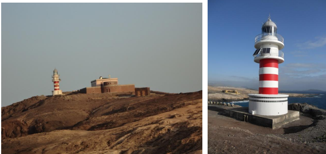
Figura 5.29. Rehabilitación del faro como restaurante (izda) y rehabilitación del propio Faro (dcha).
