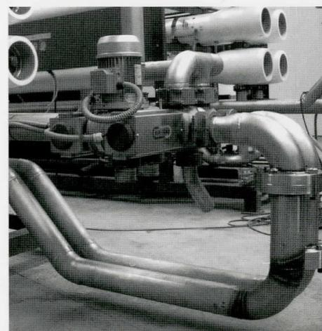
IDAM en Cabo Verde con sistema de recuperación de energía RO KINETIC, desarrollado y patentado en Canarias. (Fuente: Manuel Barreto)
