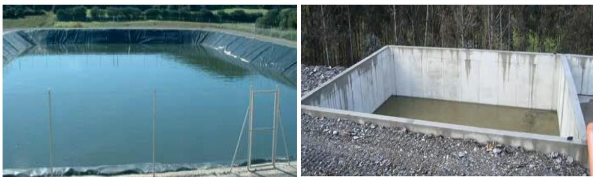
*Figura 3. Almacenamiento de purín en balsa en tanque exterior. Fuente: MAPA, 2015*
