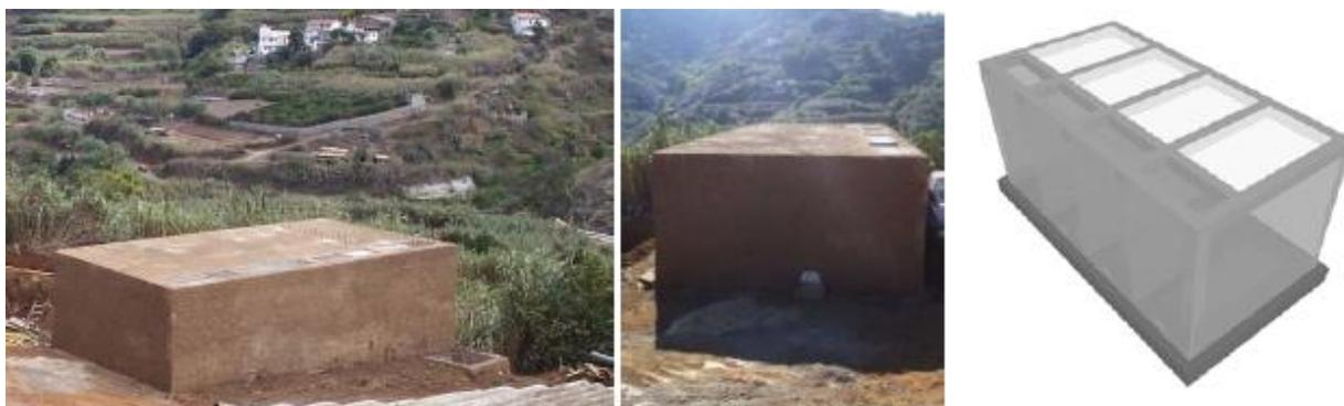
Figura 25. Digestor de mezcla completa en la planta piloto. Fuente: Mendieta, 2015.
