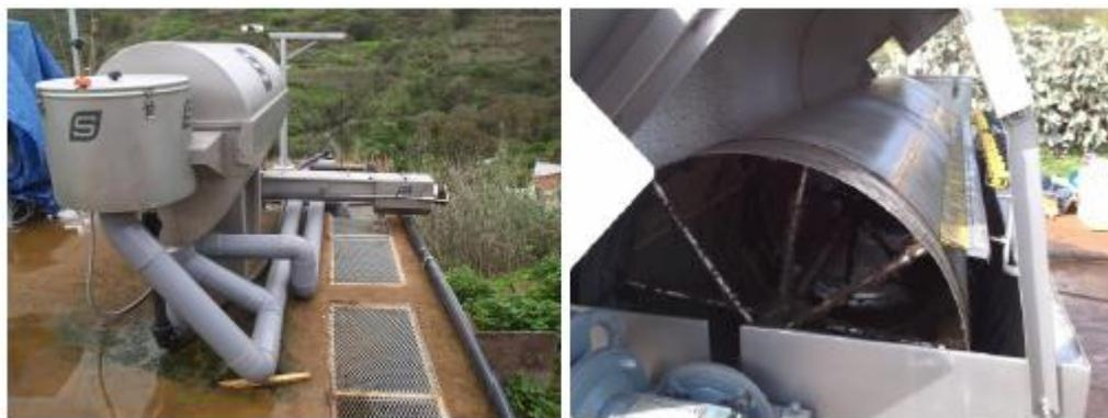
Figura 24. Tamiz rotativo planta piloto. Fuente: Mendieta, 2015.
