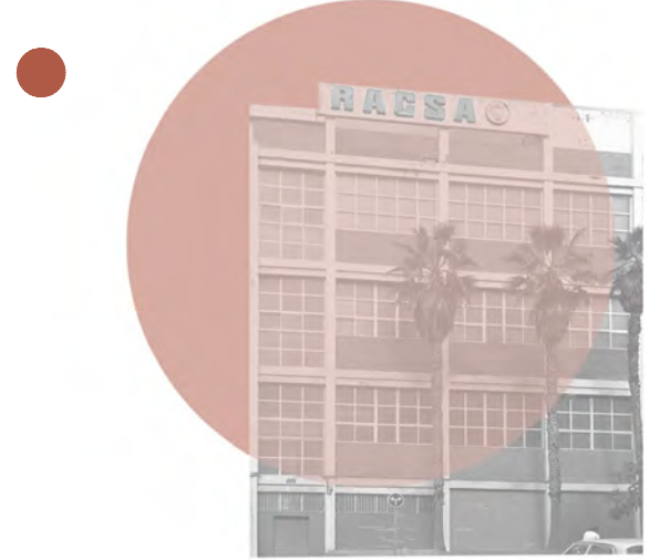
6 · Antigua fábrica RACSA
