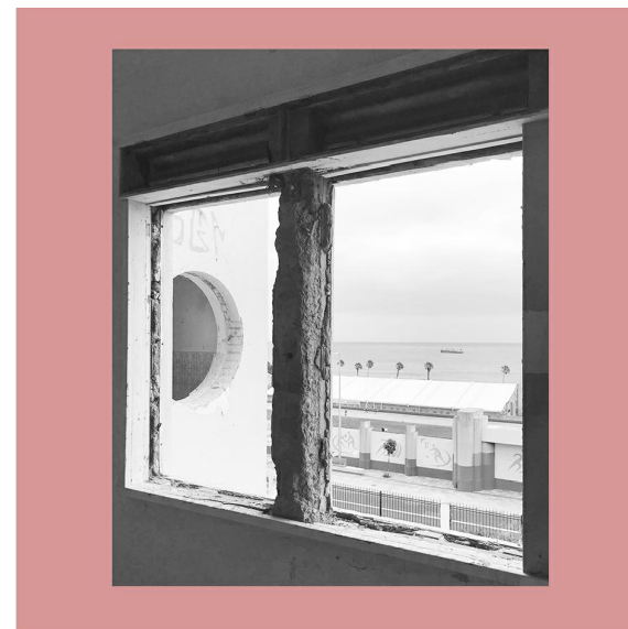
Detalle pilar planta segunda
