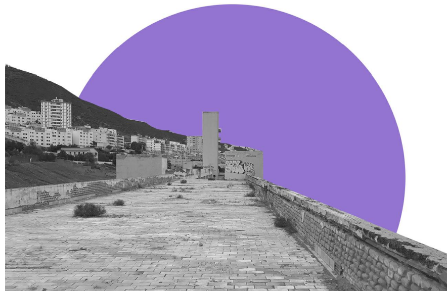
Vista exterior cubierta pabellón sur
