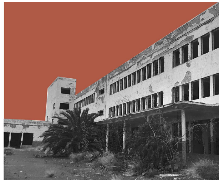
Humedades de fachada y pretil
