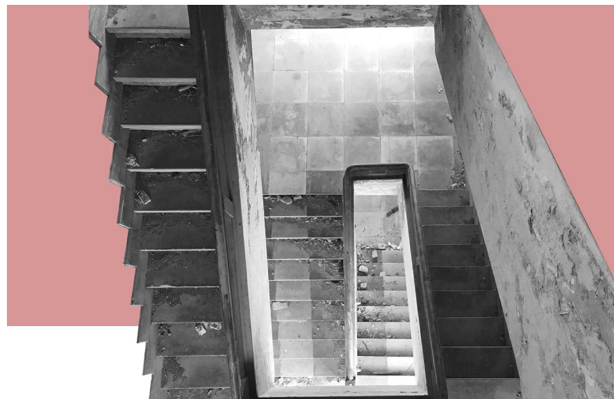
Detalle escalera principal pabellón sur
