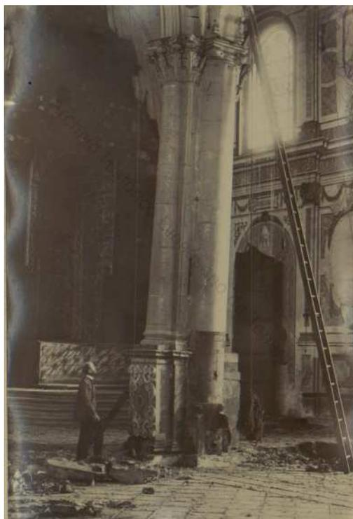
**Figura 2.** El Ingeniero militar Julio Cervera realizando una inspección para proceder al apeo de la estructura.<sup>5</sup>
