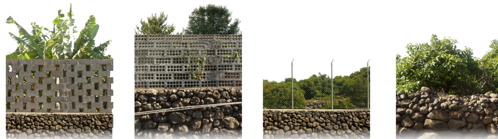
Tipologías de muros agrícolas
