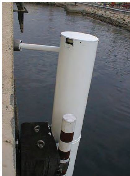
Figura 2.3: Mareógrafo SONAR ubicado en el Puerto de la Coruña. Fuente: Puertos del Estado
