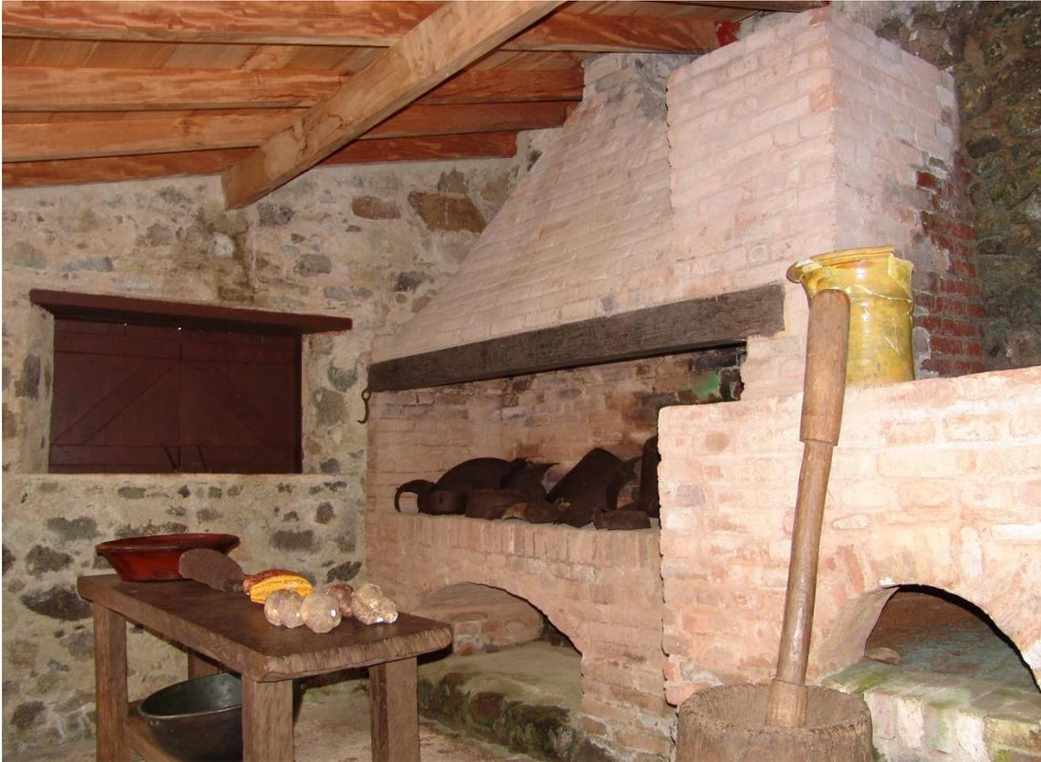
Fotografía 7.42: interior de la cocina externa, en las proximidades de la casa principal de La Isabelica. Destacan el fogón para cocinar con fuego (en el centro de la imagen), el horno de pan (de pequeñas dimensiones, a la derecha de la imagen), la campana de extracción de humos y la tipología del techo, Captura del 8 de abril de 2007.
