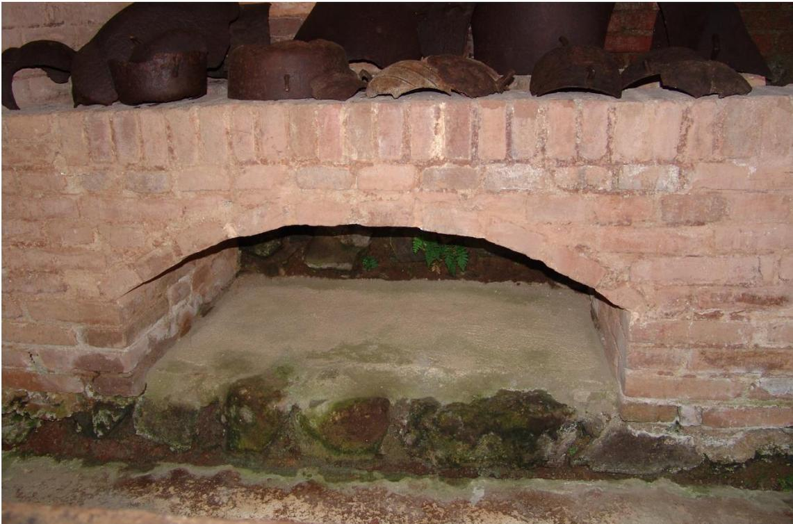
Fotografía 7.43: interior de la cocina externa, en las proximidades de la casa principal de La Isabelica. Destaca el hueco para conservar la leña seca, debajo del fogón para cocinar con fuego. Captura del 8 de abril de 2007.
