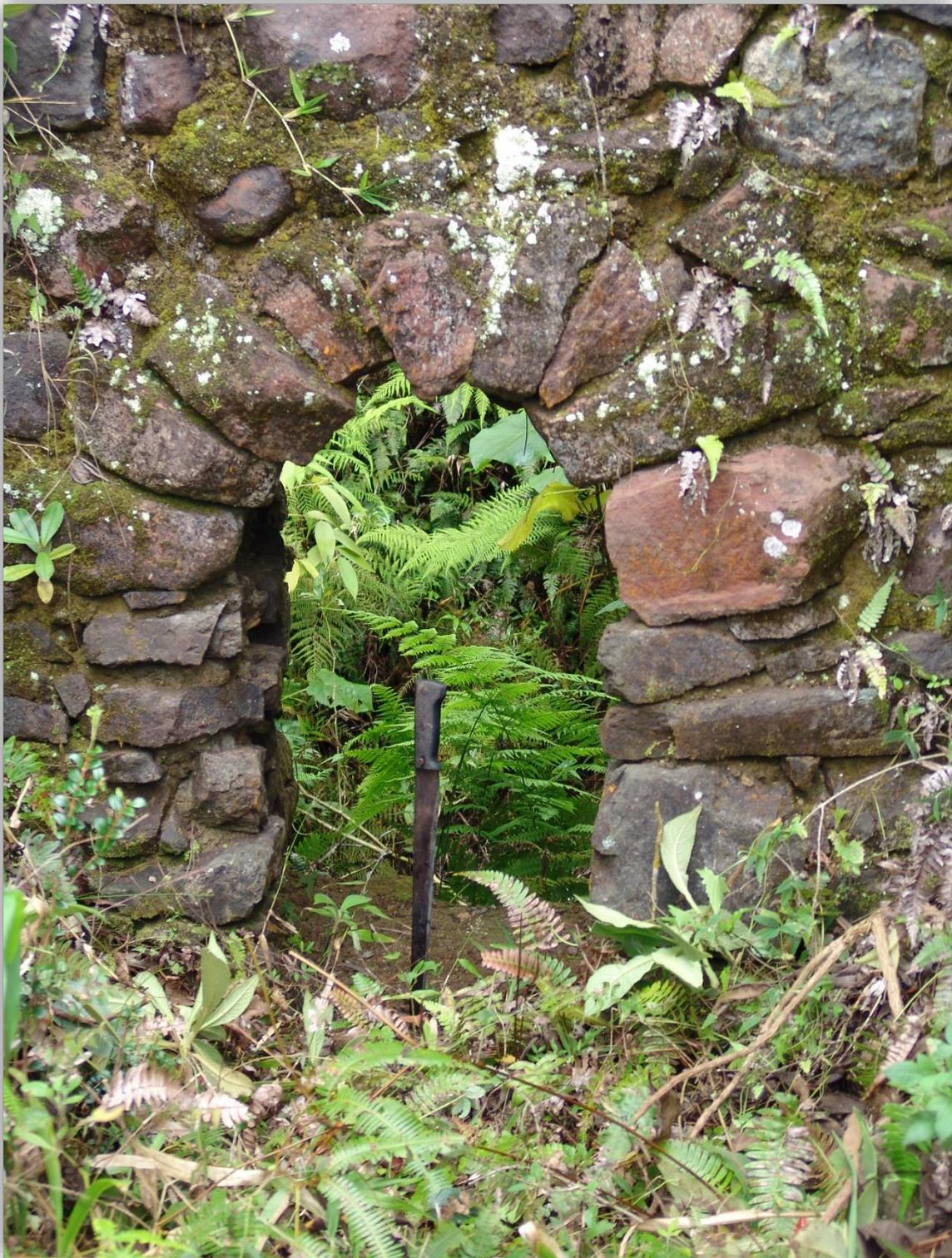
Fotografía 7.59: vano de entrada al horno de cal, en el Cafetal La Isabelica. El machete, clavado verticalmente casi en el centro del vano, sirve de escala. Captura del 8 de abril de 2007.
