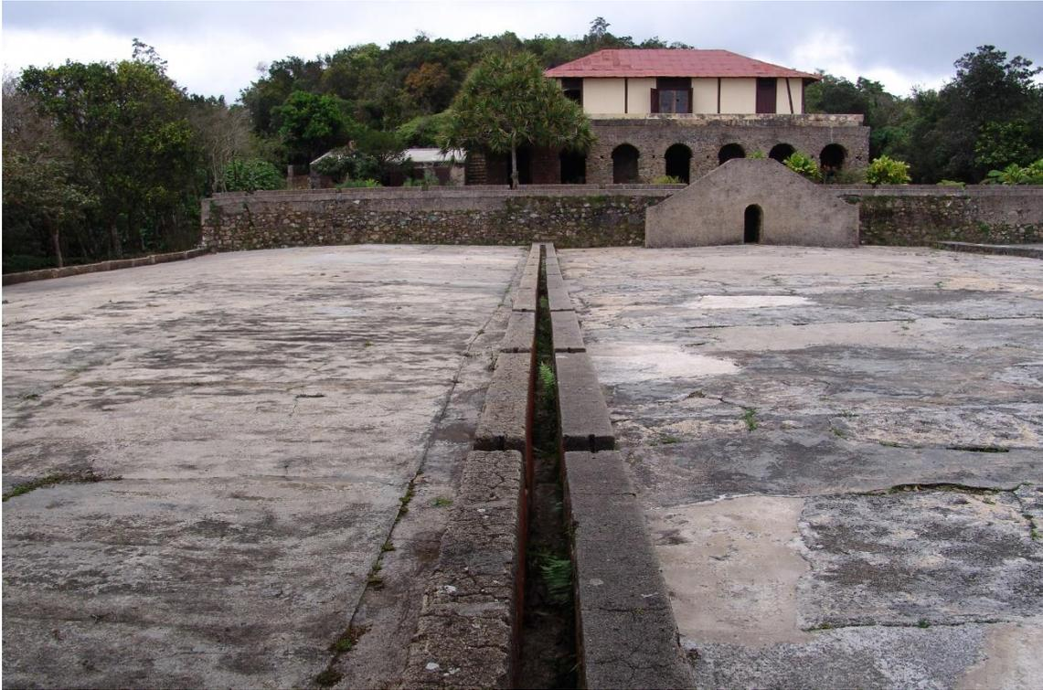
Fotografía 7.56: vista parcial de los secaderos, con sus pendientes para el drenaje del agua de lluvia, del Cafetal La Isabelica. Captura del 16 de marzo de 2007.
