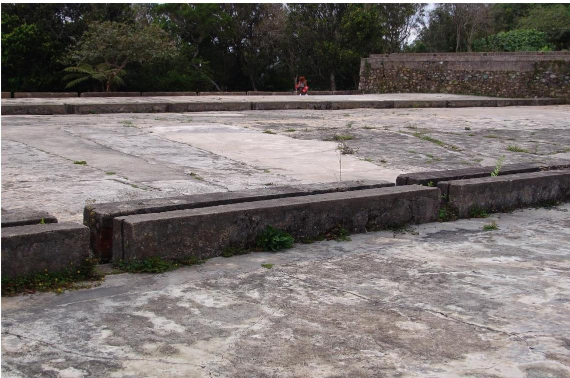
Fotografía 7.57: vista parcial de los secaderos del Cafetal La Isabelica. Se aprecia, casi en un primer plano, uno de los canales de desagüe, delimitados por pretiles rebajados. Los pretiles tienen ranuras. Entre estas, hay un espaciado regular. A través de estas ranuras, y cuando llueve, se produce el drenaje general, para que no se acumule el agua de las precipitaciones sobre la superficie de los secaderos. Captura del 16 de marzo de 2007.
