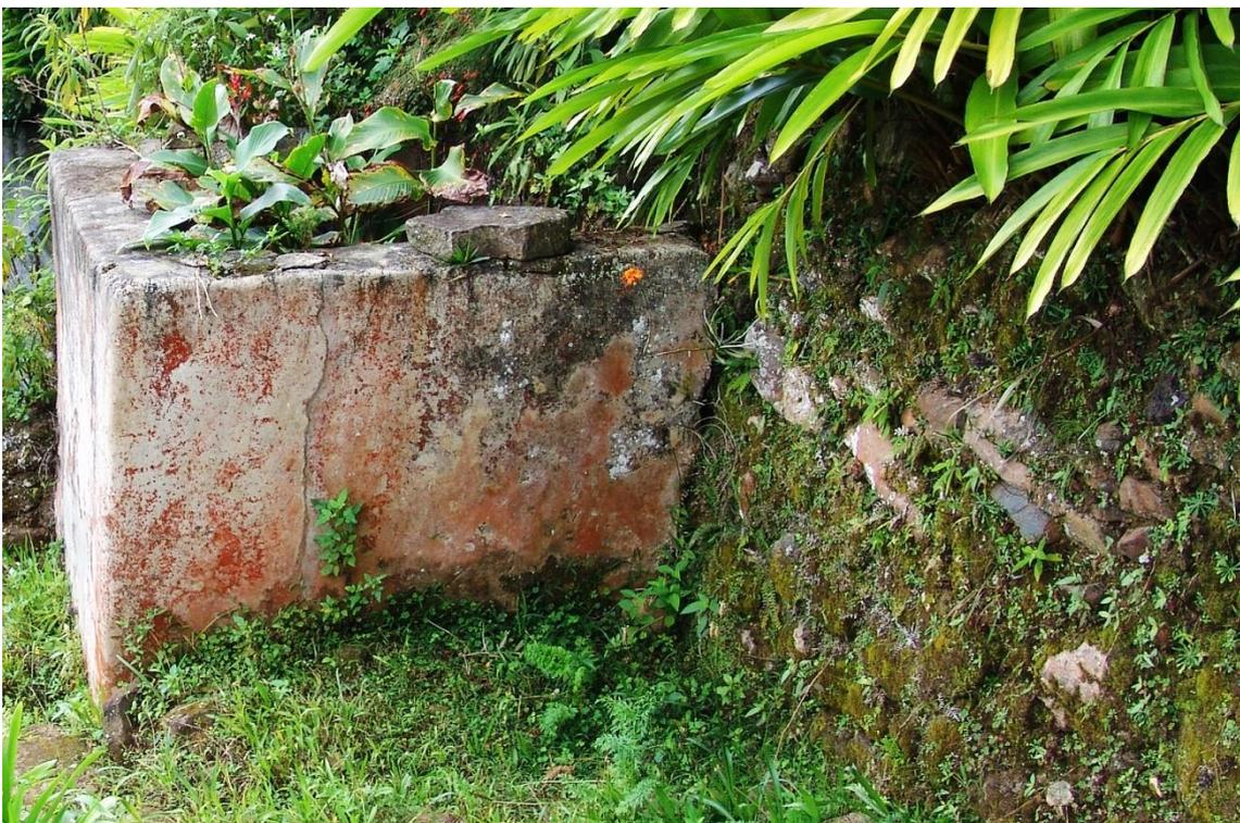
Fotografía 8.17: tanque (aljibe) que recibía agua a través del acueducto principal. El agua almacenada en el tanque llegaba a la casa de los amos a través de un canal doméstico. Captura del 8 de abril de 2007.
