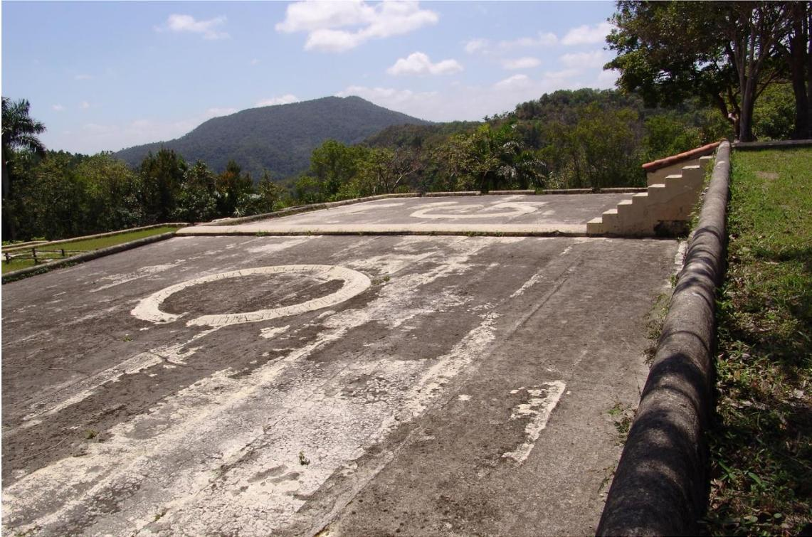
Fotografía 1.30: secaderos de la última terraza. En la restauración, y sobre las superficies cementadas (como se encontrarían originariamente) se mantienen las zonas circulares, delimitadas por bordillos, con ranuras para el drenaje del agua de lluvia. Las cerezas de los cafetos, para que se secan, se expandían en estas zonas acotadas. Cafetal franco-haitiano Buenavista (Complejo de Moka en Sierra del Rosario, dentro de la Cordillera Guaniguanico (Cuba). Captura del 18 de marzo de 2008.
