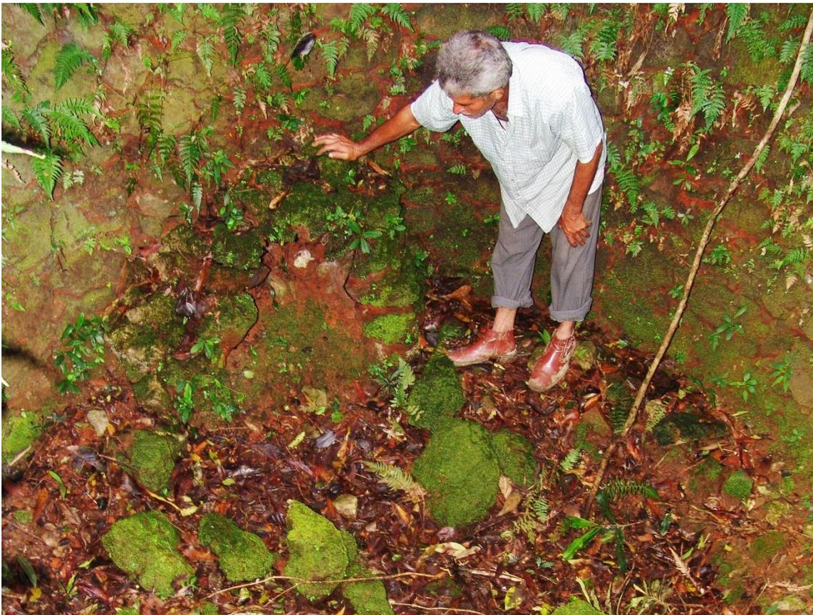
Fotografías 8.18 y 8.19: horno de cal del Cafetal franco-haitiano La Siberia. En la imagen de abajo, don Luís Reyes Merino focaliza hacia el fogón, donde se iniciaba el fuego para la obtención de cal desde rocas calcáreas. El horno tenía un acceso lateral. Capturas del 8 de abril de 2007.
