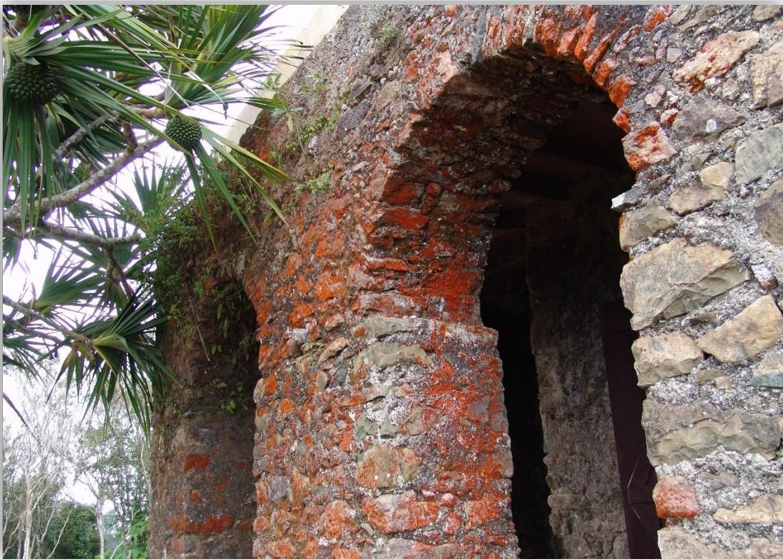
Fotografías 7.29 y 7.30: vistas y detalle de los soportales, con arcos de medio punto, en la planta baja (basamento) de la casa principal del Cafetal La Isabelica. Estos corredores porticados dan acceso a dependencias restauradas de servicios diversos. Capturas del 31 y 16 de marzo de 2007 (de arriba abajo).
