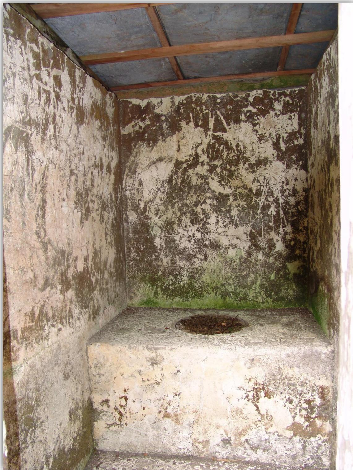
Fotografía 7.39: interior de la letrina externa y próxima a la casa principal de La Isabelica. Destaca la construcción de una obra, generalmente sobre un pozo negro séptico, para evacuar los excrementos. Captura del 16 de marzo de 2007.
