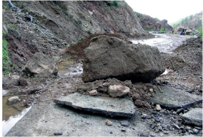
Figura 2. Desprendimientos de rocas afectando a una carretera principal de la red de la isla de Gran Canaria, Islas Canarias. Fuente: fotografía I. Galindo.
