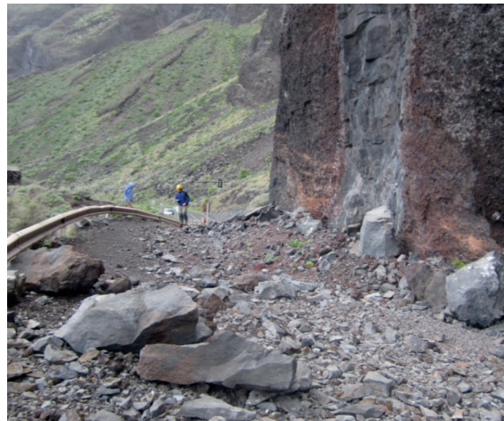
Figura 3. Vía de tránsito cortada debido a los desprendimientos de rocas en la isla de El Hierro. Fuente: fotografía I. Galindo.
