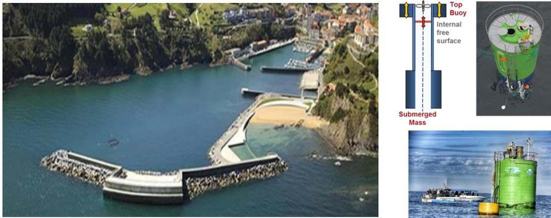
Figura 7. Estructura OWC en el Puerto de Mutriku (España) y Dispositivo OCEANTEC.
