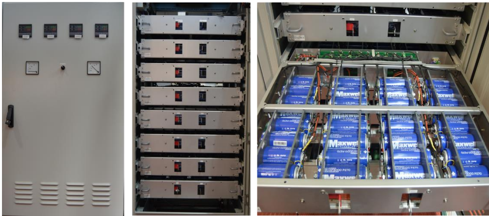
Figura 103. Módulo formado por 256 supercondensadores Maxwell Technologies perteneciente al laboratorio de ensayos CIEMAT. Fuente: elaboración propia.
