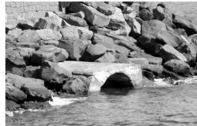
diámetros de salida de agua insuficientes
