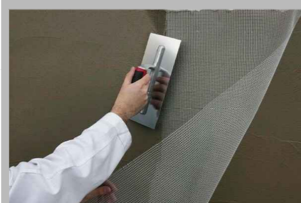
Revestimiento exterior de enfoscado con armadura de retracción
