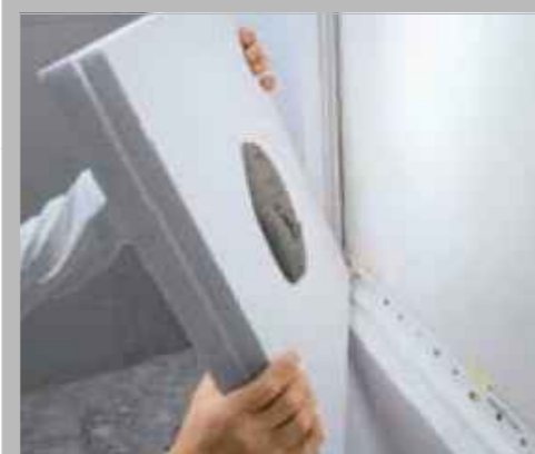
Fijación de adhesivo cementoso
