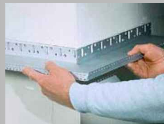
Soporte inferior del aislamiento térmico
