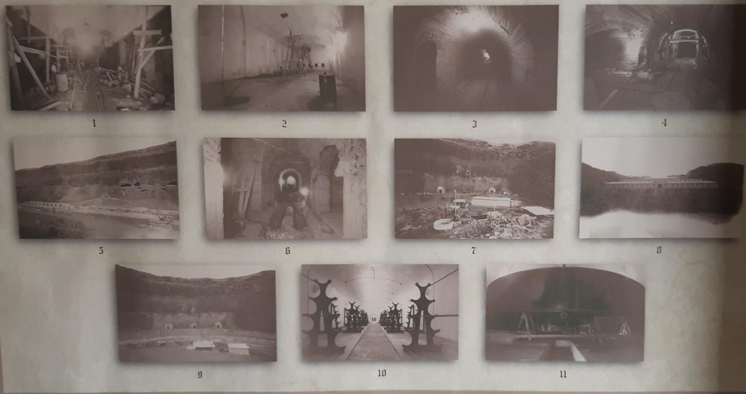
1 BASE NAVAL DE CANARIAS. Zona "Guanarteme" Galería principal.
