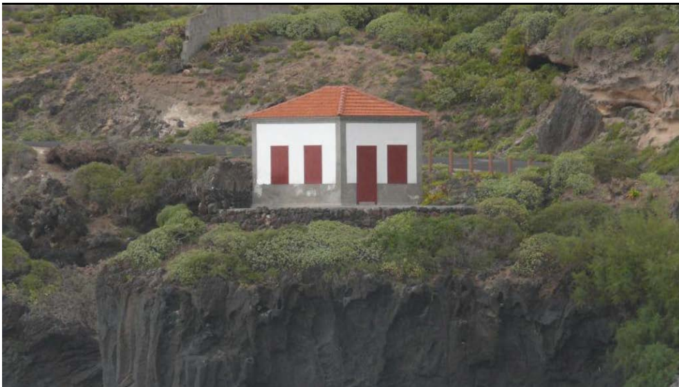
Figura 3: "Caseta del Cable", (restaurada en 2001), punto de amarre del cable Tenerife-La Palma en Los Silos, Tenerife
