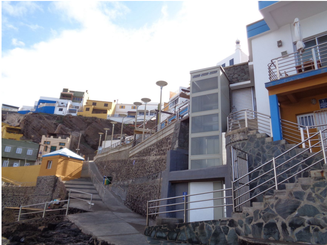
Figura 25: Ubicación ascensor PMR y vista rampa acceso 1. Elaboración propia.
