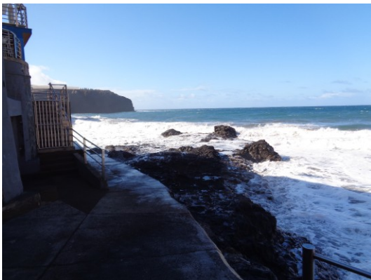
Figura 24: Rampa acceso playa Izquierda. Elaboración propia.
