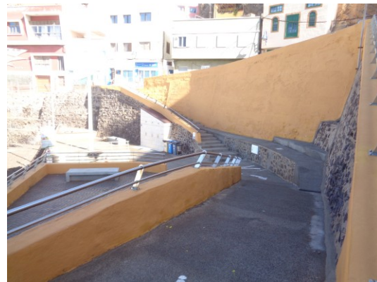
Figura 17: 2º tramo Acceso 1. Elaboración propia.
