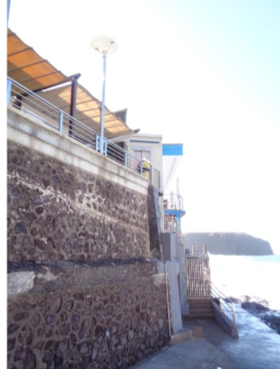
Figura 21: Salida del ascensor. Elaboración propia.
