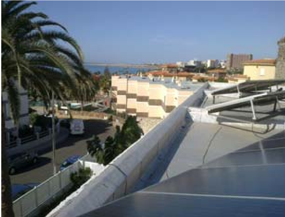
Figura 2: Conjunto de paneles fotovoltaicos instalados sobre cubierta.
