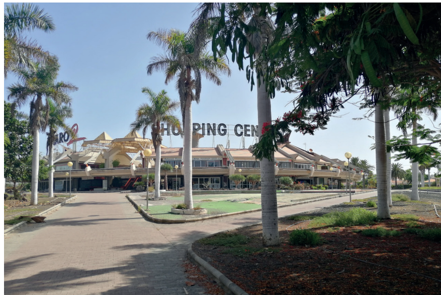
Fig. 2-85: Caminos y jardines exteriores al Centro Comercial Faro 2. Fuente: Google Earth
