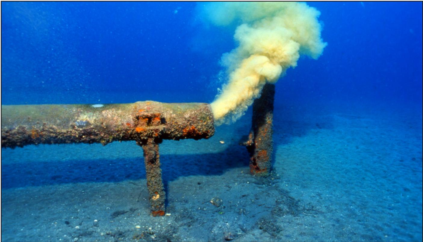
**Foto 15.** Vertido de aguas residuales urbanas a través de un emisario submarino.
