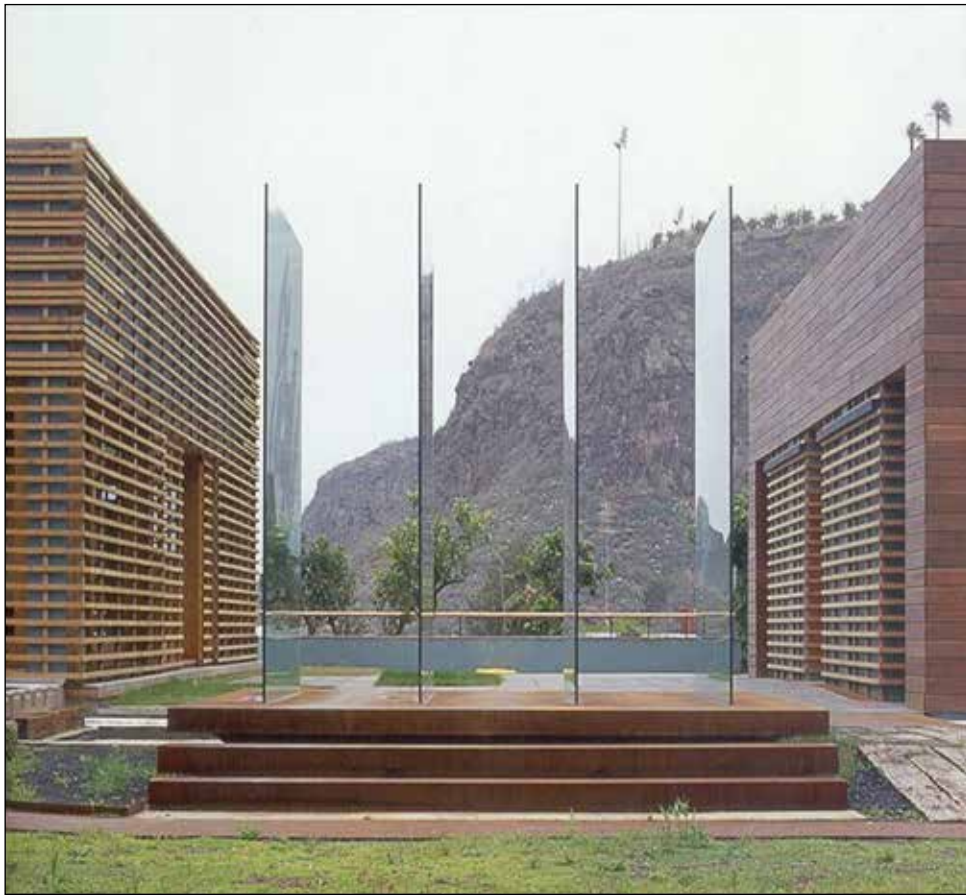
Proyecto “Reutilización de nave agrícola para la sede del Consorcio del Guiniguada”, Barranco Guiniguada, Gran Canaria, 2002
