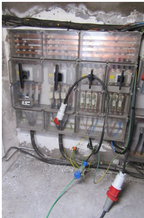
Fig. 5.7- Acometida eléctrica para el sistema de refuerzo sonoro. Esta instantánea fue tomada en el cuarto de enganche (bajo nivel de suelo, con acceso mediante canaleta). Se puede ver la toma de 63 A en CETAC que serviría de suministro a los cuadros eléctricos de la empresa, para todo el sistema de sonido.
