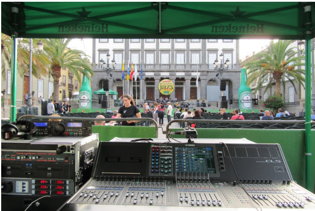
Fig. 5.9- Posición del control de PA en la Plaza de Santa Ana. A la izquierda de la imagen se puede observar el cuadro de corriente con sus indicadores para los equipos de dicha posición de control.
