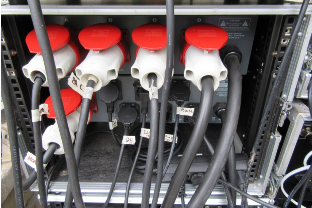
Fig. 5.8- Salidas del cuadro de corriente general de Sowe. Instalación de la Plaza de Santa Ana. En la imagen se puede observar que todas las salidas de 32 A del cuadro se encuentran debidamente etiquetadas, así como las salidas en schuko del cuadro menor.
