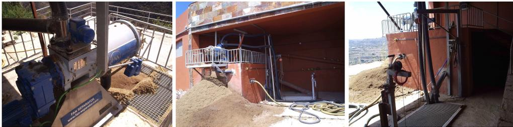
**Figura 6.** Tamiz rotatorio, digestor anaerobio y depósito de retención.
