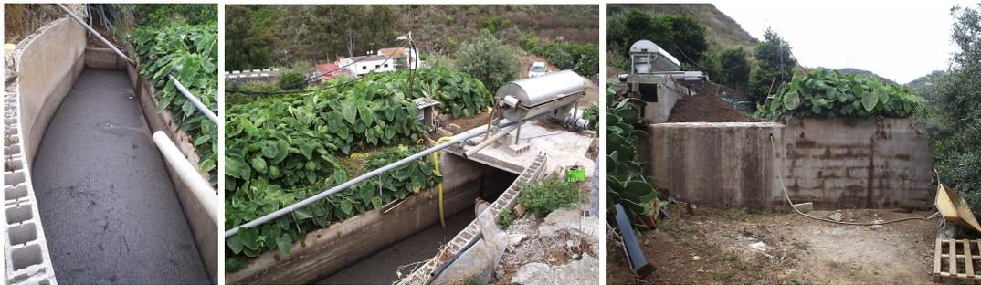
**Figura 8.** Depósito de retención, tamiz rotativo y digestor anaerobio.
