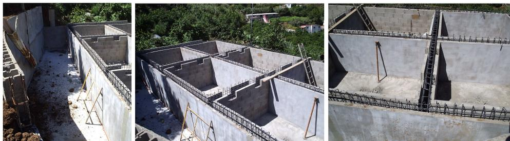
**Figura 10.** Depósito de retención y muros de las cámaras.
