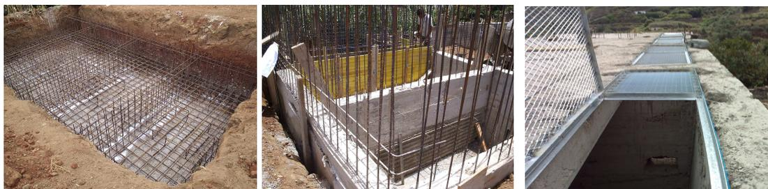
**Figura 9.** Losa de sedimentación, muros de las cámaras y forjado de cubierta.
