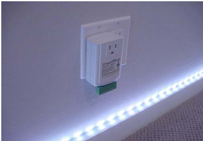
Figura 2. Un ejemplo de tira de LED que se puede utilizar para la señalización reconfigurable, por ejemplo, colocados sobre el zócalo por toda la pared.
