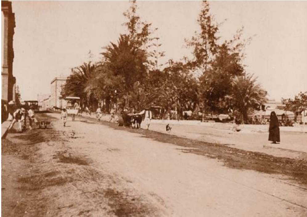
Obras en la carretera junto a San Telmo
