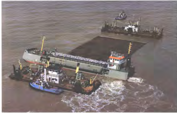
De positie van afzinkposten, zinkstuk en stenslurter gedurende het afzinken.
