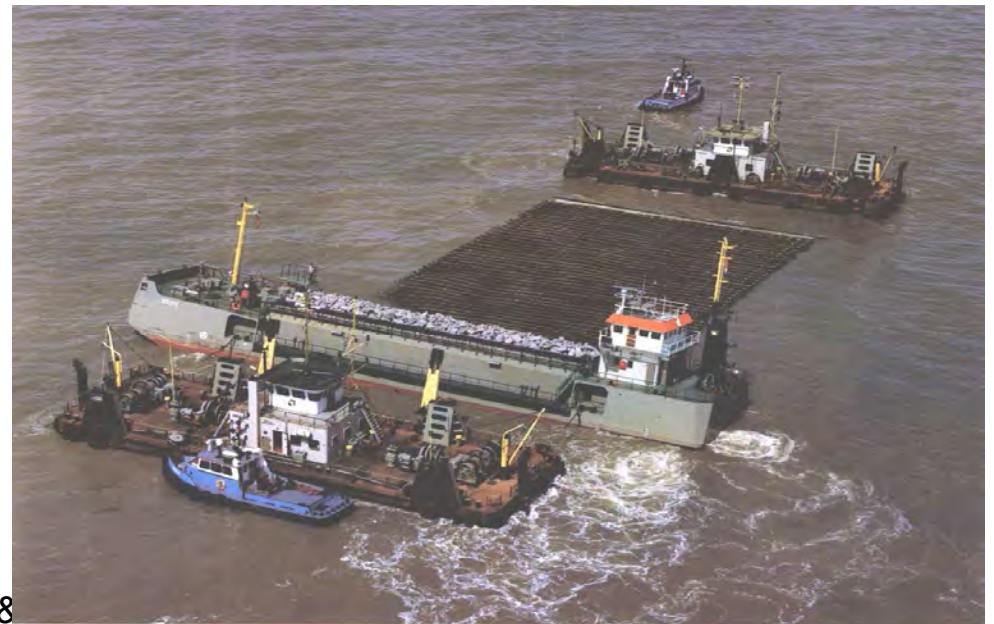
De positie van afzinkpontons, zinkstuk en steenstorters gedurende het afzinken.
