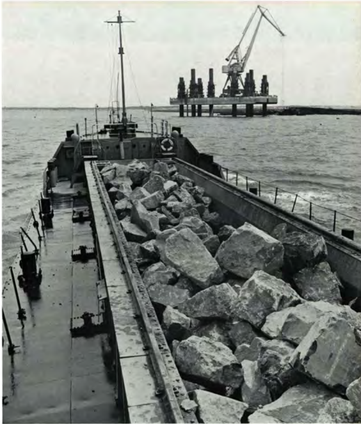
13. De twee belangrijkste concepties van de Combinatie IJmuiden: onderlossers en hefpontons met kraan, beide geadviseerd en in opdracht van Rijkswaterstaat ontworpen.
