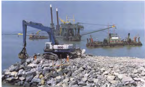
De positie van afzinkposten, zinkstuk en stenslurter gedurende het afzinken.
